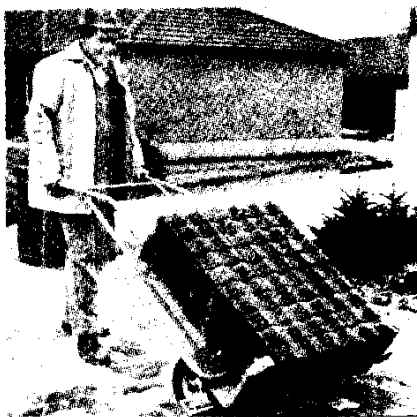
شکل ۹ . حمل بلوک با فرغون مخصوص
