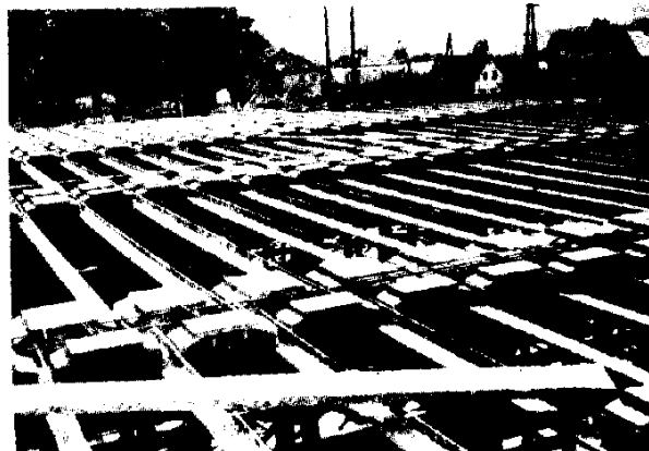
شکل ۱۶. تنظیم فواصل بین تیرچه‌ها با نصب دو بلوک انتهایی
