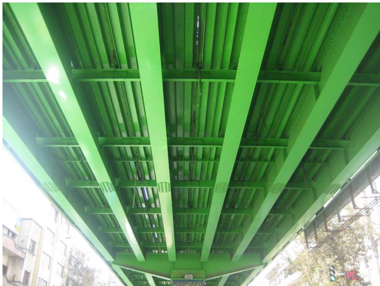
شکل ۱- نمایی از یک سر پایه پل کالج
