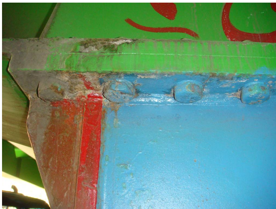
زنگزدگی پیچ‌های اتصال پایه به سرپایه
