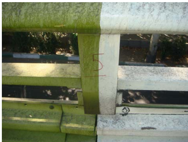
شکل ۳-۴- نمونه‌هایی از آسیب موجود در نرده‌ها و فلاشینگ‌ها
