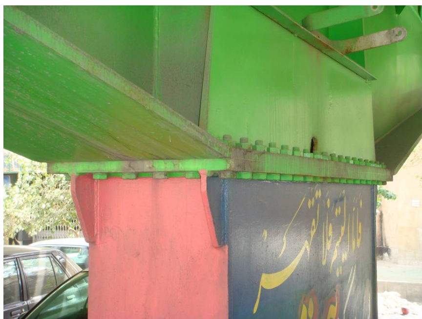
نمایی از اتصال پایه و سرپایه
