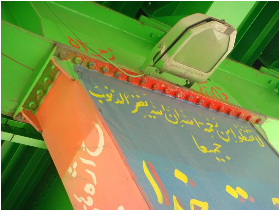
نمایی از اتصال پایه و سرپایه محور ۱۰
