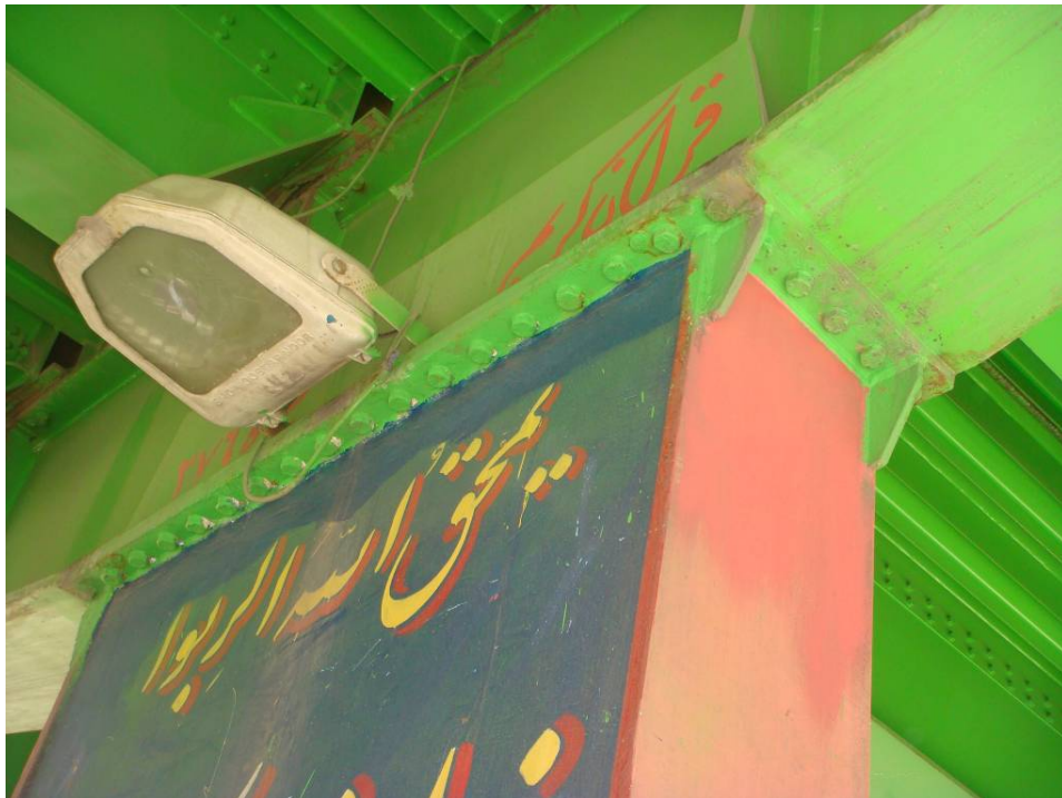
زنگ زدگی پیچ‌های اتصال پایه به سرپایه
