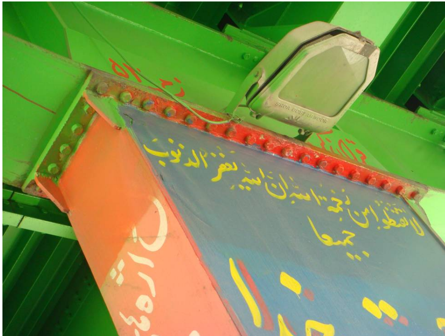
نمایی از اتصال پایه و سرپایه محور ۱۱
