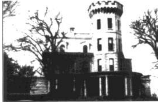
شکل ۲-۷- اولین ساختمان ساخته شده از بتن مسلح در ایالات متحده، ویلیام وارد، ۱۸۷۵-۱۸۷۱
