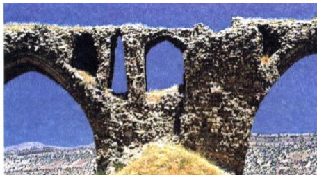
مصالح سنگی و فرم خاص قوس پل کشکان
