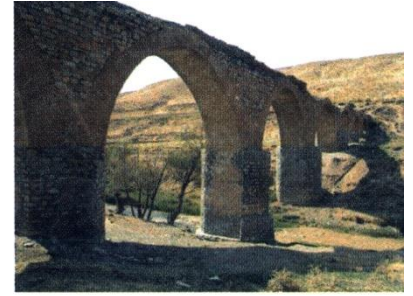
پل قلعه حاتم بروجرد
