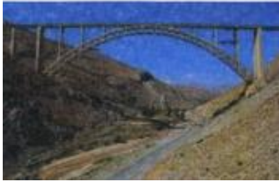
پل قطور , خوی: پل فلزی , سیستم سازه ای آن , قوس فولادی خرپایی , فرم کلی پل طاقی است
