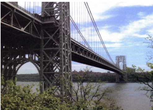
پل جورج واشنگتن ، نیویورک طویل ترین پل معلق دنیا ، ساخته شده با کابل و تیرهای فولادی ، دارای دو برج فولادی که در یک فونداسیون بتنی مسلح و پوشیده شده با گرانیت فرو رفته است . در این پل از به کار بردن خرپای فلزی تثبیت کننده سنتی اجتناب شده است .
