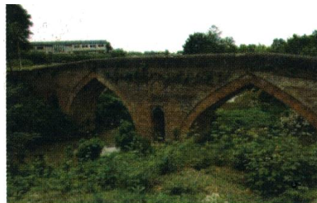
پل صفویه لاهیجان، از جمله پل های دوران صفویه
