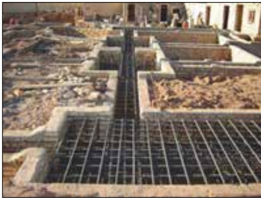
شکل ۳-۱۳۴ میلگردگذاری در پی کلاف بندی
