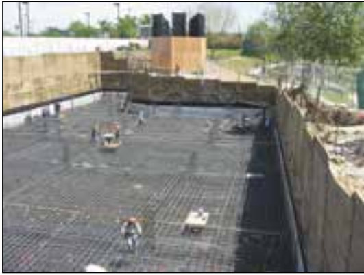
شکل ۳-۶۸ پی بتن مسلح یکپارچه (رادیه ژنرال)
