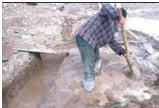
شکل ۳-۳۷ اجرای شفته آهک در فونداسیون
