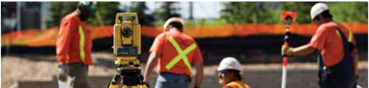
شکل ۴-۱. پیاده کردن با دوربین نقشه‌برداری
