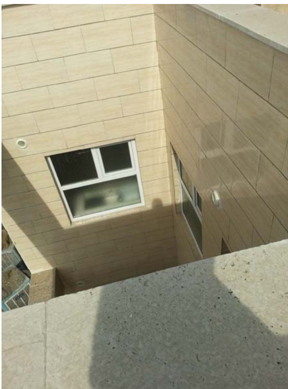
شکل ۲۱- عدم اجرای درپوش جانپناه بام و عدم اجرای قرنیز کف پنجره
