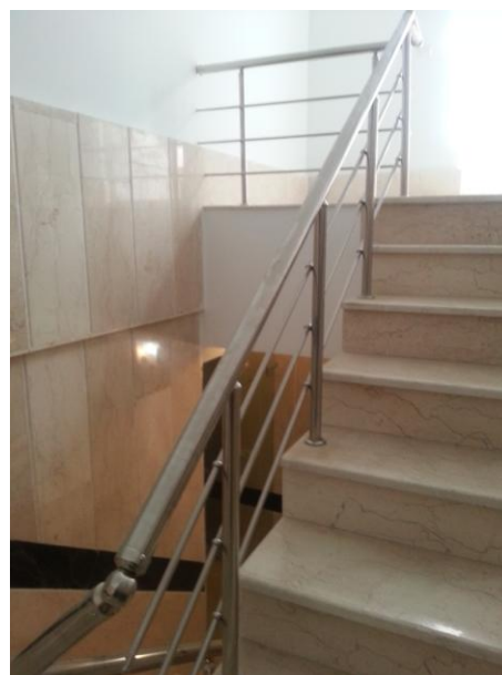
شکل ۲۰- استاندارد نبودن ارتفاع نرده دست انداز پله و فاصله قیدها در خرپشته
