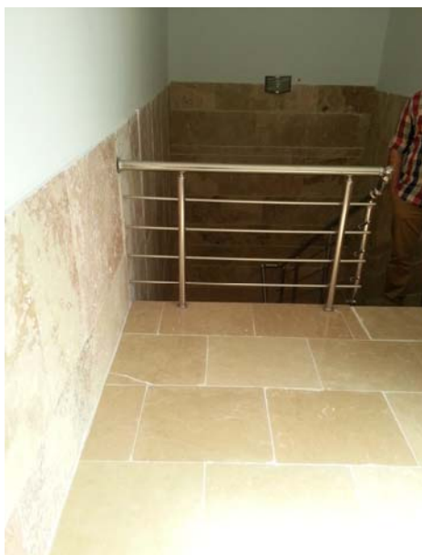
شکل ۲۰- استاندارد نبودن ارتفاع نرده دست انداز پله و فاصله قیدها در خرپشته
