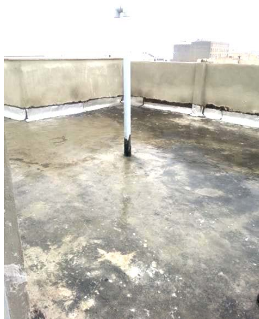
شکل ۱۲ - عدم استفاده از درپوش برای جانپناه شرقی و غربی و عدم دیوار کشی و محافظت اطراف لوله های ونت
