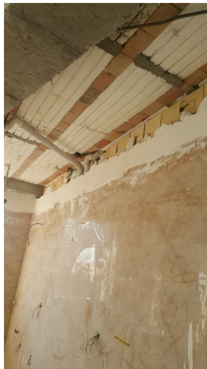
شکل ۷- عدم هشتی مناسب تیغه به سقف و عدم گیری و اتصال صحیح بین دو دیوار
