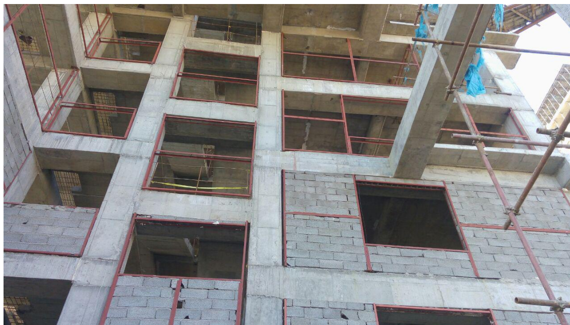
شکل ۵- اجرای وال پست ها جهت اجرای دیوارها
