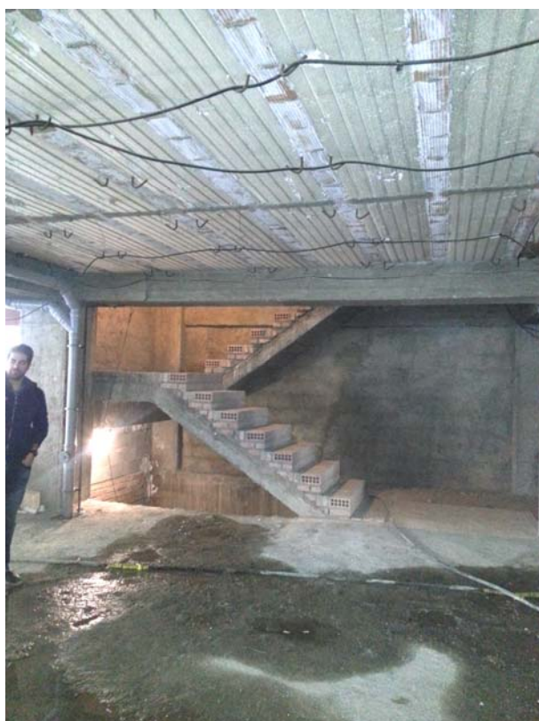
شکل ۱۴ - عدم وجود نرده موقت و پاخور در اطراف پرتگاهها
