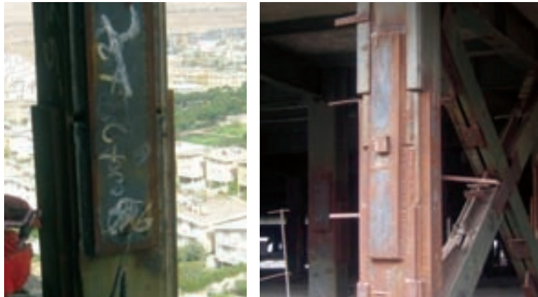
شکل ۸-۲۴- وصله جوشی ستون جعبه‌ای
