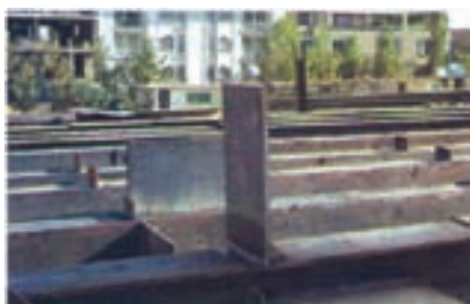
نصب ورق زیرسری روی ستون در کارگاه
