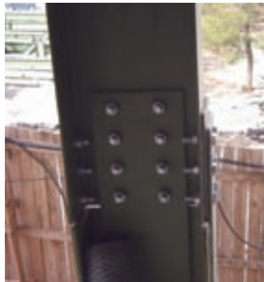
شکل ۸-۲۵- اتصال ستون به ستون بصورت پیچ و مهره‌ای
