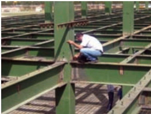
اتصال اعضای قاب در اسکلت فولادی
