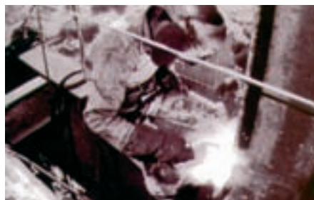
نصب و جوش ورق روسری در محل نصب
