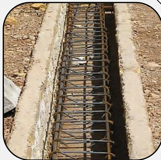
(اجرای میلگردهای شناژها)
