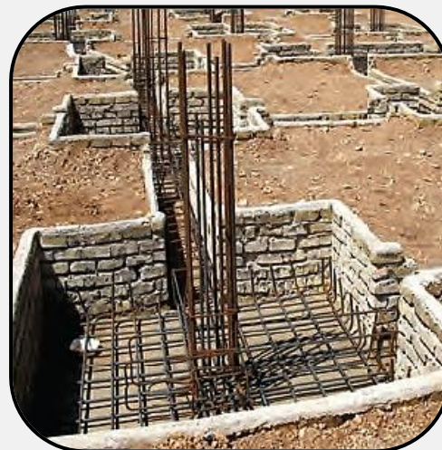
(اجرای میلگردهای ریشه انتظار برای سازه‌های بتنی)
