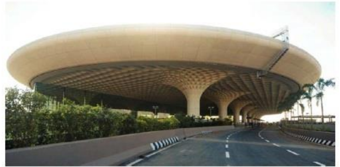
شکل ۴- نمای بیرونی از سازه و سقف ترمینال ۲ فرودگاه بمبئی، هند
