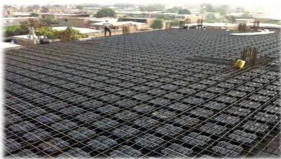
در این مرحله قالب‌های U-Boot طبق نقشه‌های اجرایی چیده و فاصله آنها به وسیله بندهای تعبیه شده بر روی آنها تنظیم می‌گردد.
