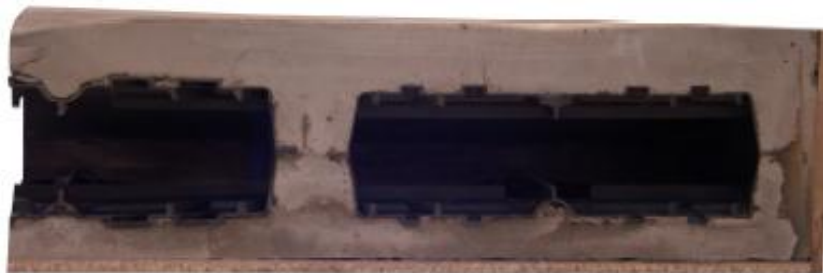
شکل 8- مقطع سقف یوبوت دابل
