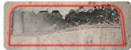
شکل 5- عکس مقطع دال با یوبوت تک
