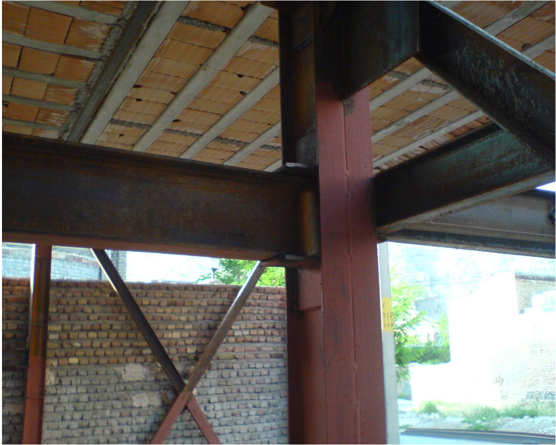
اتصال ساده تیر به ستونو اتصال تیر به ستون تقویت شده
