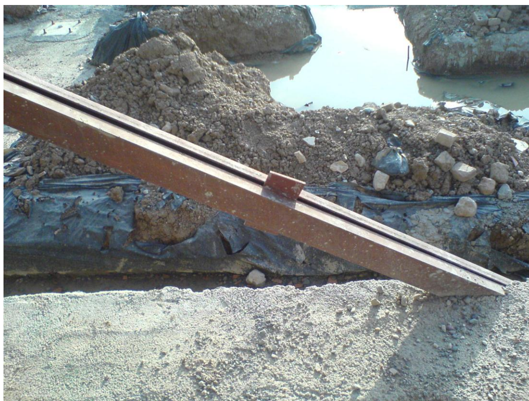
گذاشتن لقمه مابین پرو فیل های دابل بادبند
