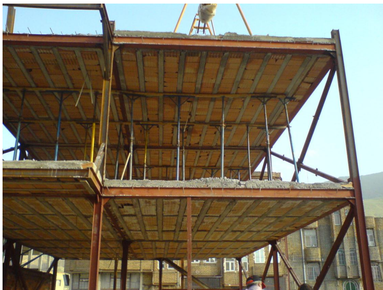
شمع بندی سقف تیرچه بلوک با شمع فلزی
