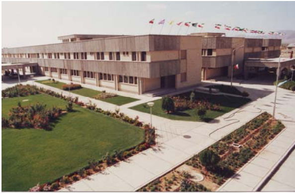
نمای تلفیقی بتن و آجر
