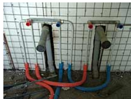
کار گذاری لوله های تاسیساتی
