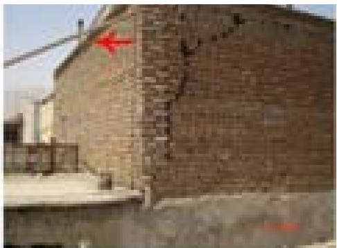
عدم استفاده از شناژ افقی، اتصال نامناسب دیوار به سقف، لغزش سقف بر روی دیوار
