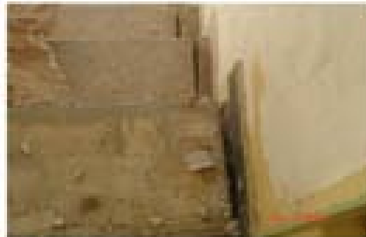
جابجایی دیوار کنار راه پله به دلیل ارتفاع زیاد ساختمان و تخریب بخش هایی از خرپشته
