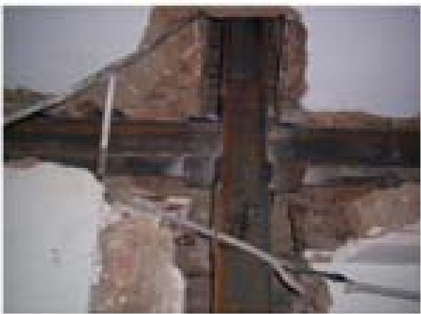
اتصالات شناژهای قائم و افقی
