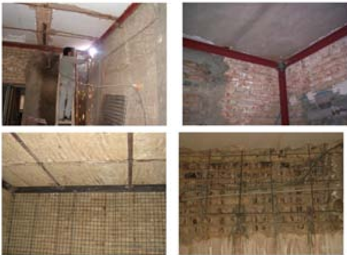
شکل ۴-۱۴ اجرای نبشی کشی
