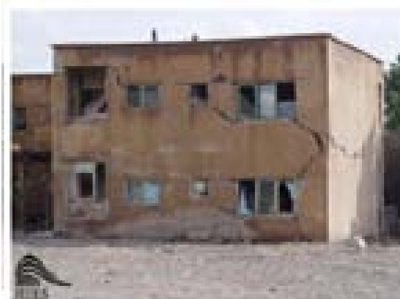
وجود ترک های عمیق قطری در دیوارهای ساختمان سازمانی اسلام آباد
