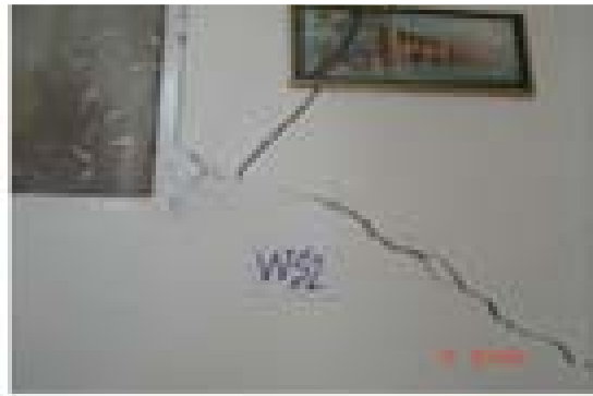
ضعف تیغه های داخلی در تحمل برش (ضخامت کم و عدم شکل پذیری که جزء خصوصیات رفتاری مصالح بنایی می باشد)
