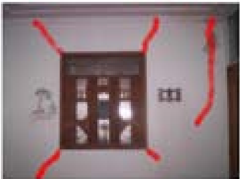
ترک های مرزی بین دیوار برشی و شناژ قائم، ترک های کنج بازشو به علت ابعاد زیاد بازشو نسبت به دیوار
