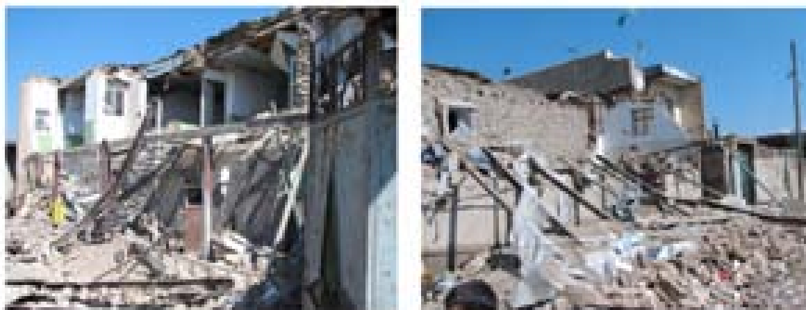
شکل ۱-۴ تصاویری از آسیب های وارده در اثر زلزله لرستان
