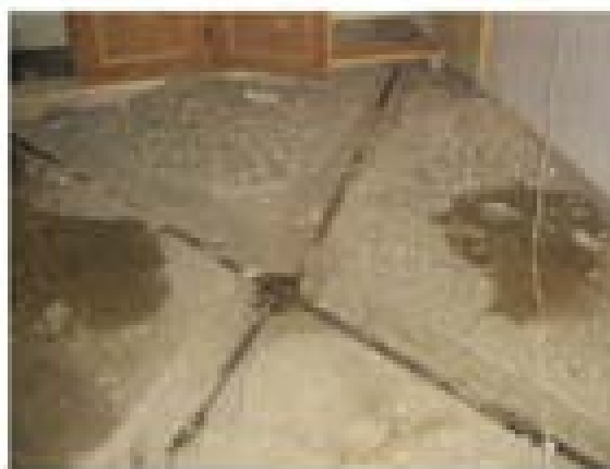
شکل ۴-۱۱ تسمه کشی
