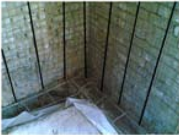
شکل ۴-۲۴ اجرای آرماتورهای عصبایی
