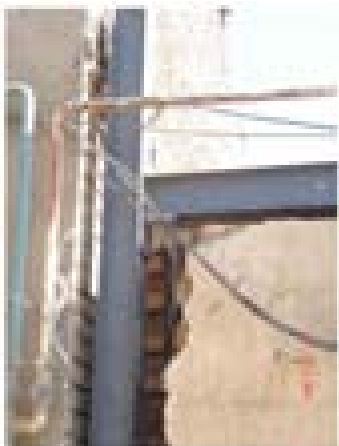
اجرای شناژهای افقی باربر ثقلی در محل هایی که باربری را از دیوار به شناژ های افقی منتقل کرده ایم، و شناژ افقی با مقطع مناسب برای آن طرح شده است.
