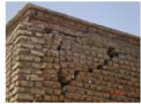
عدم استفاده از شناژ افقی، اتصال نامناسب دیوار به سقف، لغزش سقف بر روی دیوار
