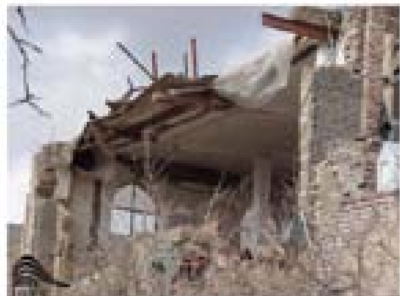
تخریب دیوار باربر پیرامونی در روستای داهوییه
