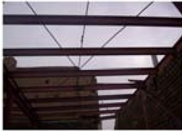
شکل ۴-۱۲ تعویض سقف چوبی
