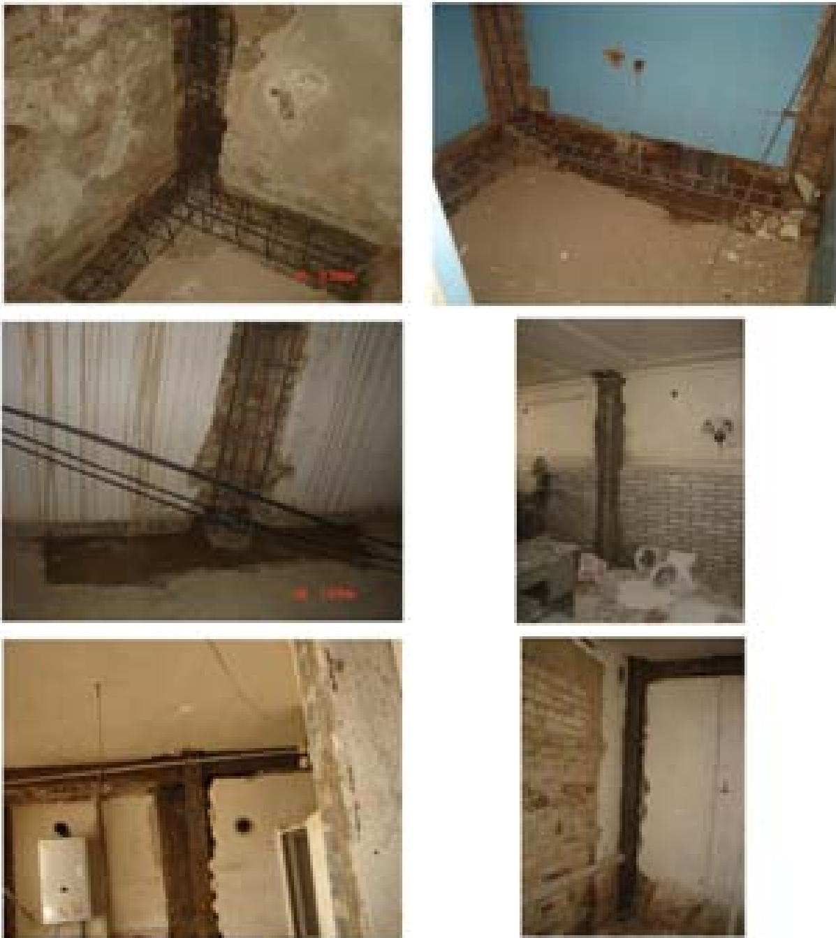
شکل ۴-۱۳ اجرای شناژ قائم
