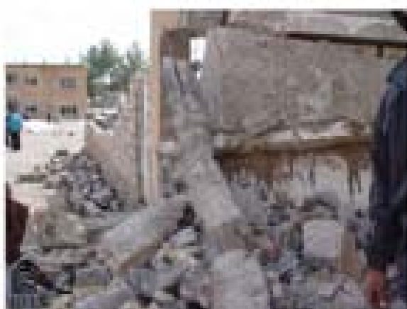
استفاده از یک میلگرد در ساخت شناژ افقی زیر سقف ساختمانی سازمانی در روستای اسلام آباد
