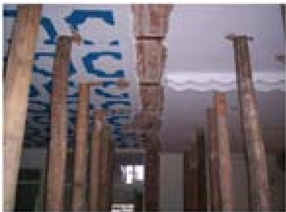
اجرای شمع بندی برای مهار بار ثقلی و ایجاد یک سیستم ایمن برای تامین امنیت
