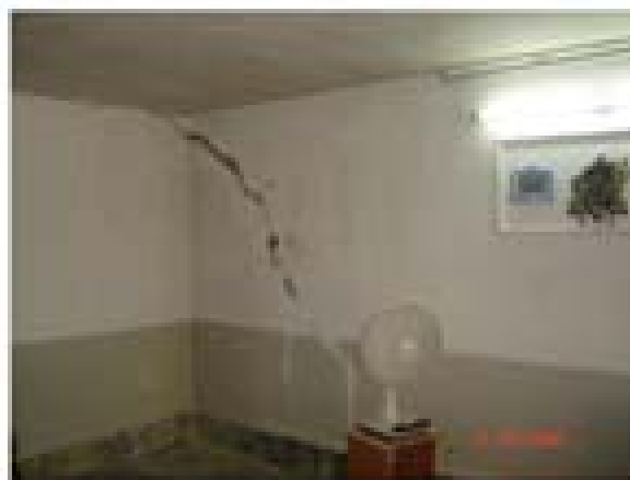
شکست برشی و ترک خوردگی دیوار به علت ضخامت کم دیوار ضعف در تحمل برش وارده
