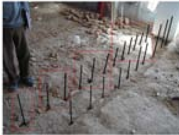
شکل ۴-۲۸ کامل نمودن مسیر های انتقال بار
