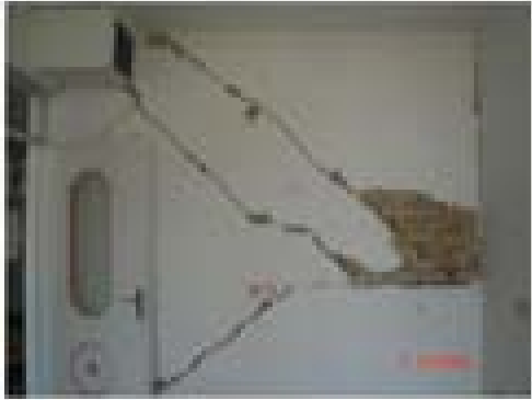
شکست برشی دیوار برشی، جداسدگی بین بند های افقی و قائم،
