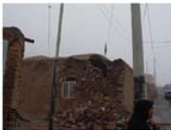
نمونه ای از تخریب در دیوارهای سنگی ساختمانی روستای خانوک
