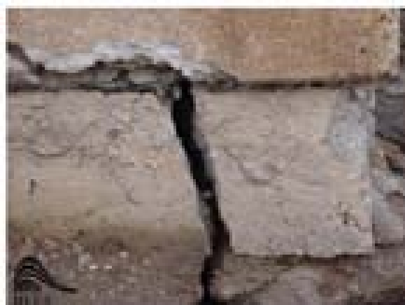
استفاده نکردن از میلگرد در ساخت شناژ زیر دیوار ساختمان سازمانی در روستای اسلام آباد
