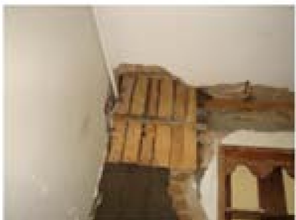
پر کردن فضای های خالی بین شناژ های قائم و دیوارها
