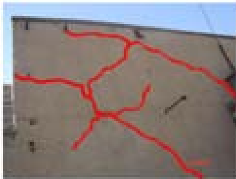
جابجایی خارج از صفحه دیوار و ترک های قطری و مورب به دلیل ارتفاع زیاد ساختمان
