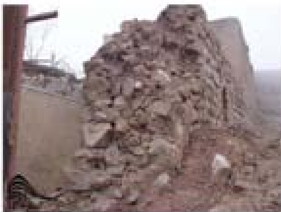
نمونه ای از تخریب در دیوارهای سنگی ساختمانی روستای خانوک
