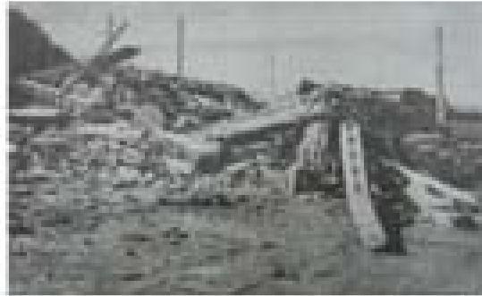
نمونه ای از خرابی های زلزله در شهر منجیل
