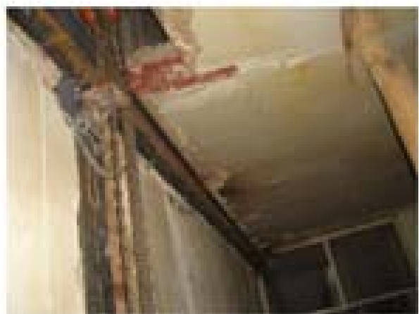
اجرای شناژهای افقی باربر ثقلی در محل هایی که باربری را از دیوار به شناژ های افقی منتقل کرده ایم، و شناژ افقی با مقطع مناسب برای آن طرح شده است.
