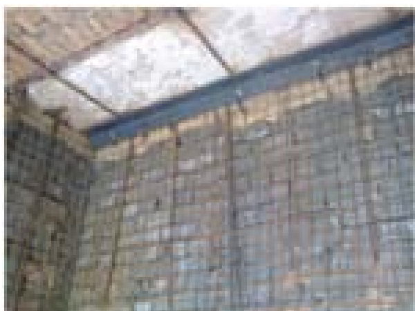
اجرای پوشش بتن مسلح توام با نبشی کشی
