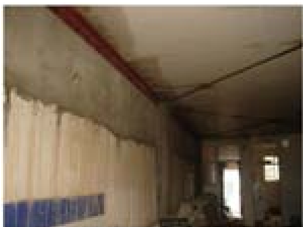
اجرای نبشی کشی در مواردی که صرفاً نیاز به تعبیه شناژ افقی می باشد و این شناژ نقش باربری ثقلی ندارد
