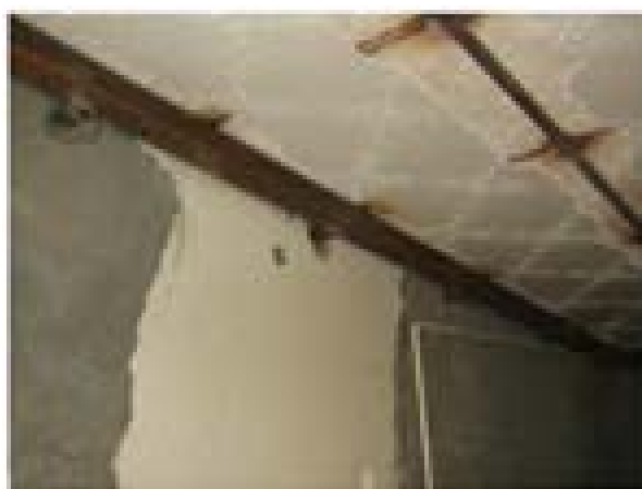
اجرای نبشی کشی در مواردی که صرفاً نیاز به تعبیه شناژ افقی می باشد و این شناژ نقش باربری ثقلی ندارد
