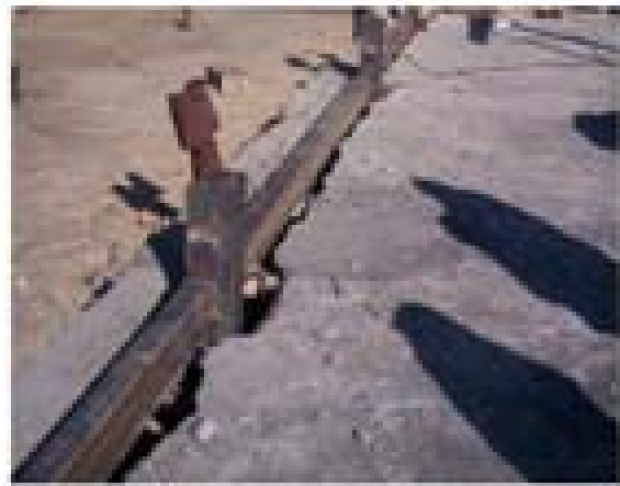
اجرای شناژهای افقی باربر ثقلی در محل هایی که باربری را از دیوار به شناژ های افقی منتقل کرده ایم، و شناژ افقی با مقطع مناسب برای آن طرح شده است.
