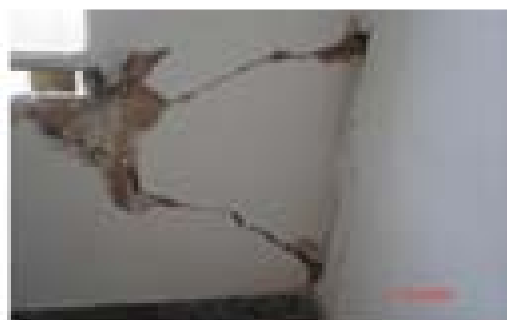
دیوارهای نمای خرپشته ها که به دلیل اینکه باربری ثقلی ندارند، به درستی اجرا نشده و در بارهای لرزه ای آسیب زیادی می بینند.
