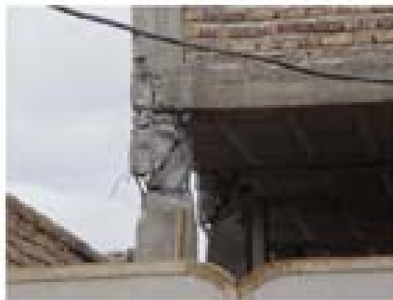
نمونه از ساختمان های بتنی، خرد شدن بتن بالا و پایین ستون ها، پاره شدن خاموت ها و کمانش میلگردهای قائم
