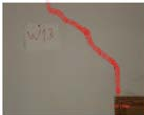
ترک خوردگی تیغه داخلی به دلیل عملکرد در تحمل بخشی از برش طبقه و ضعف دیوار به دلیل وجود بازشوی میان دیوار
