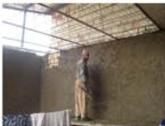
شکل ۴-۲۰ ترمیم پوشش سطحی
