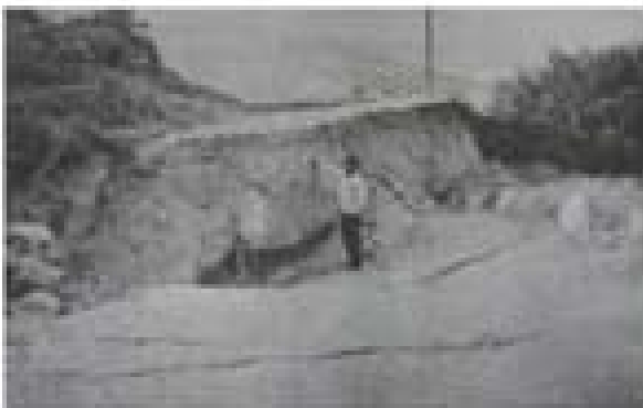
جابجایی قائم در جاده پاکده به جیرنده در حوالی گسل که ناشی از لغزش قسمتی از جاده می باشد.
