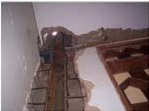
تعبیه اتصالات برشی بین شناژهای قائم و دیوارها
