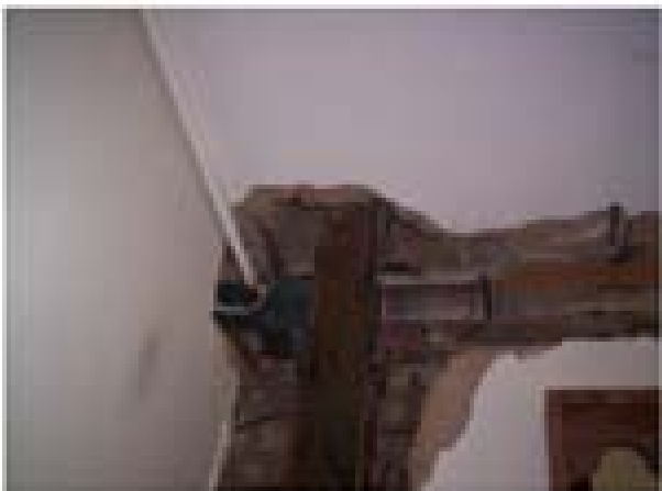
اتصالات شناژهای قائم و افقی
