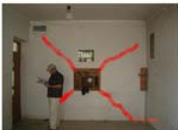
ترک خوردگی تیغه داخلی به دلیل عملکرد در تحمل بخشی از برش طبقه و ضعف دیوار به دلیل وجود بازشوی میان دیوار
