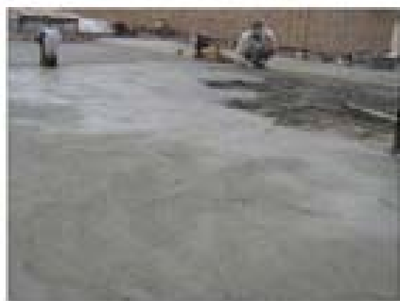
شکل ۴-۸ اجرای پوشش بتن مسلح روی بام
