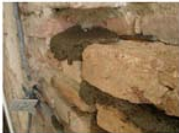
شکل ۴-۱۹ اجرای دیوار جدید
