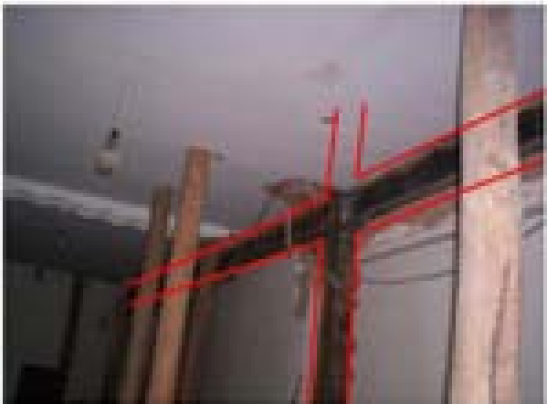
اجرای شناژهای افقی باربر ثقلی در محل هایی که باربری را از دیوار به شناژ های افقی منتقل کرده ایم، و شناژ افقی با مقطع مناسب برای آن طرح شده است.
