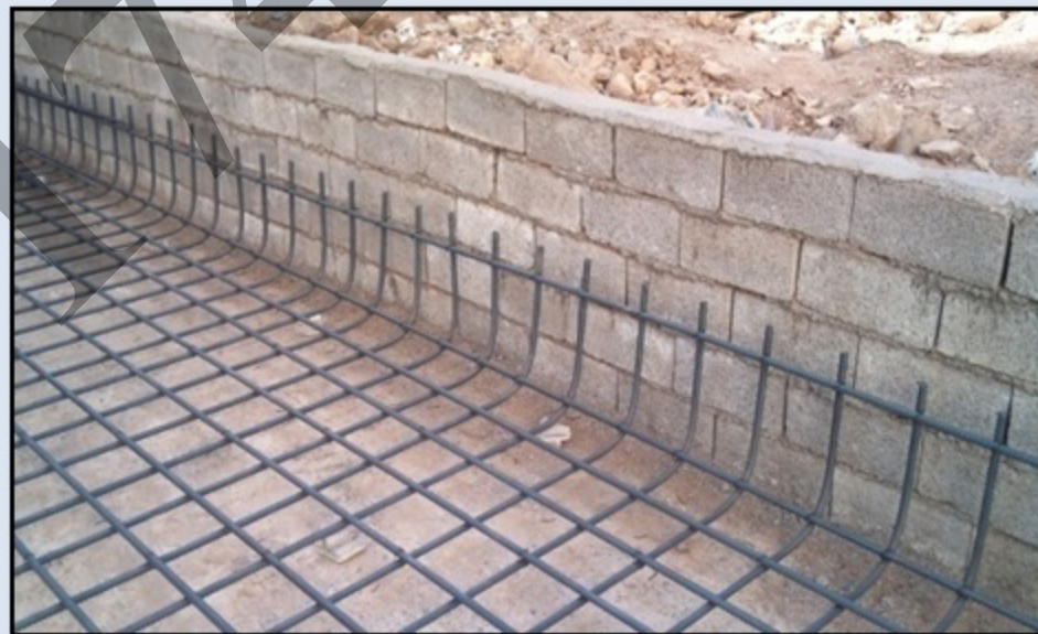
آرماتورهای تحتانی فونداسیون
