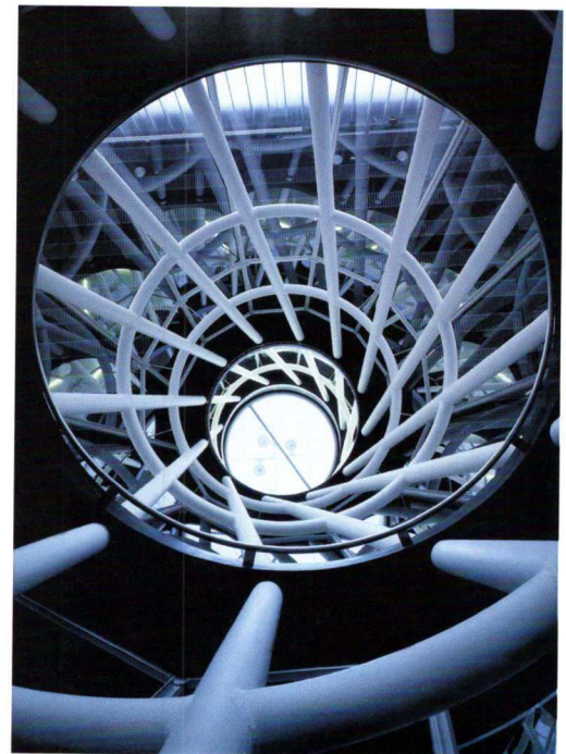
استوانه‌های سازه‌ای از فولاد سفید جهت عبور تأسیسات ساختمان
