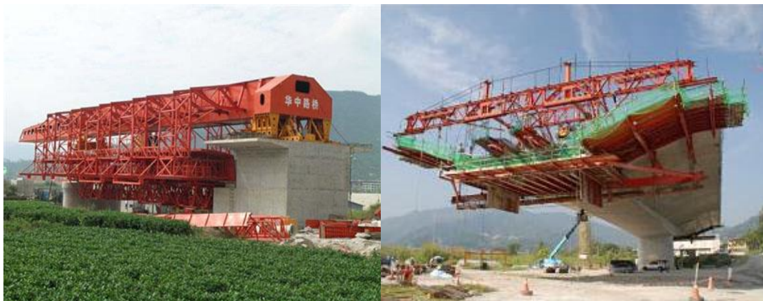
شکل (۲-۱۰): جزئیات سیستم داربست متحرک
