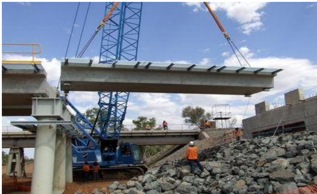
شکل (۲-۴): نصب کل دهانه با استفاده از جرثقیل
