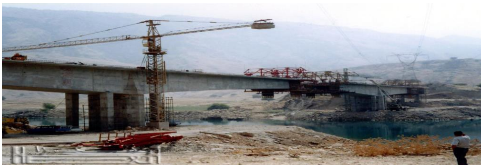
شکل (۲-۲۲): اجرای روسازه با استفاده از دستگاه شاریو
