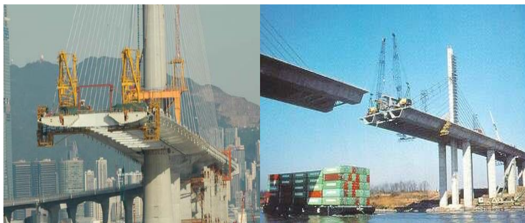
شکل (۲-۵۵): ساخت عرشه به صورت طره‌ای از دو طرف پایه‌ها
