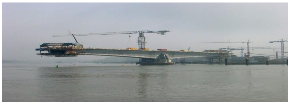
شکل (۲-۲۲): اجرای روسازه با استفاده از دستگاه شاریو
