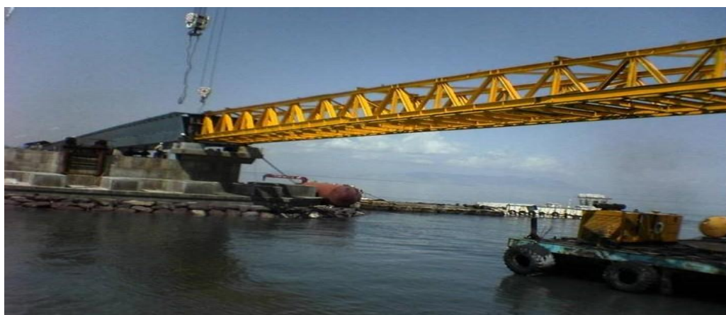
شکل ( ۲-۳۸): دماغه پیشرو - پل دریاچه ارومیه
