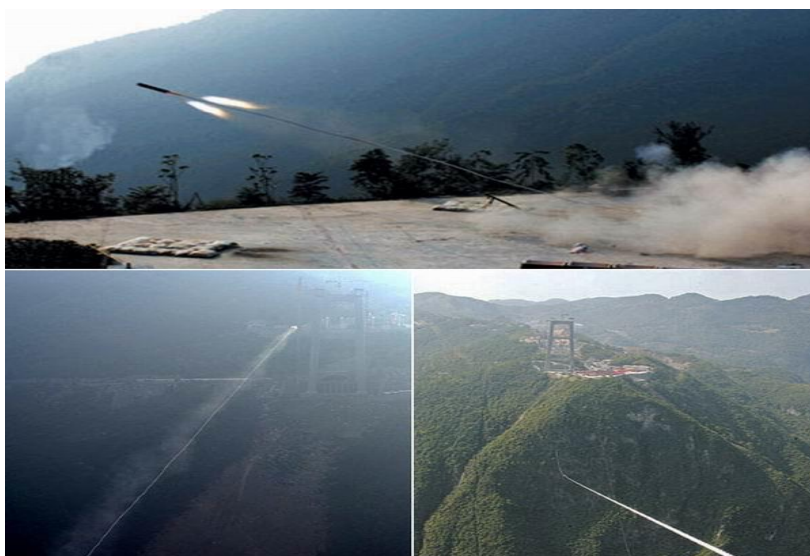
شکل (۲-۶۲): استفاده از موشک برای نصب کابل در پل معلق سیدوهه
