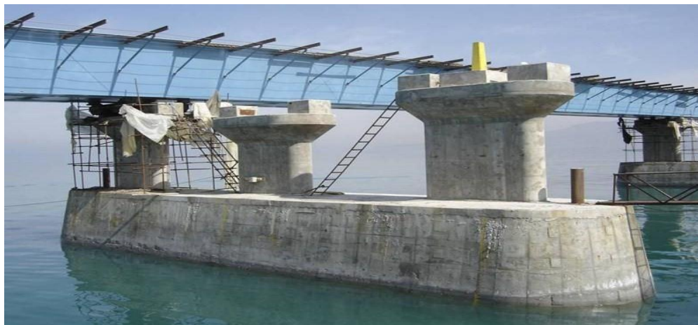
شکل ( ۲-۳۷): اجرای روسازه پل دریاچه ارومیه با استفاده از روش پیشرانی
