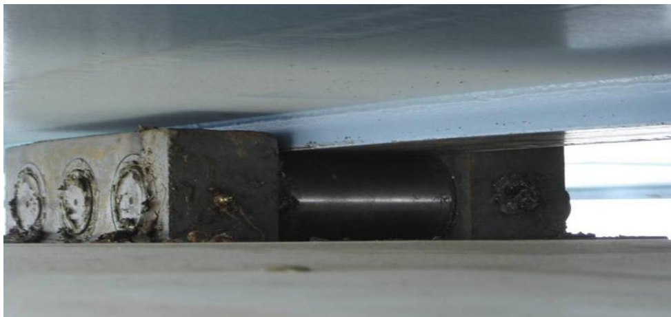
شکل ( ۲-۴۰): استفاده از غلتک بر روی سر ستون‌ها- پل دریاچه اورمیه
