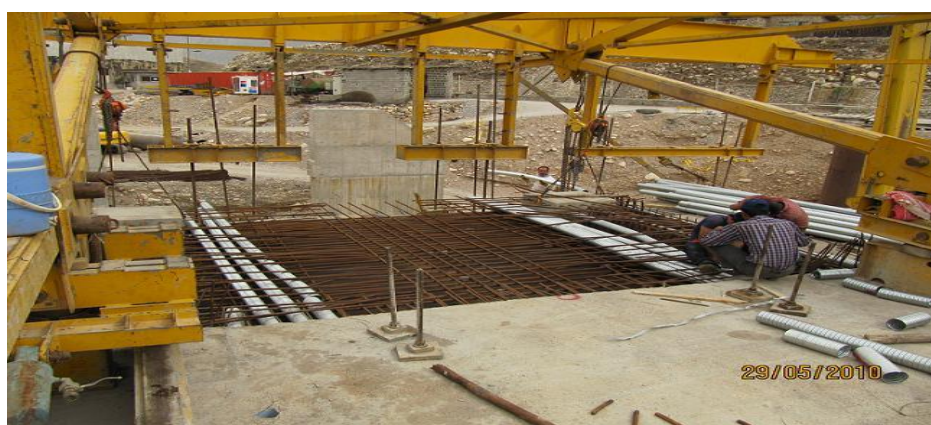
شکل ( ۲-۲۵): آماده سازی روسازه برای بتن‌ریزی روی دستگاه شاریو
