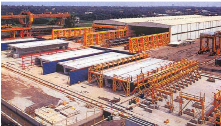
شکل (۲-۳): کارگاه ساخت قطعات پیش ساخته
