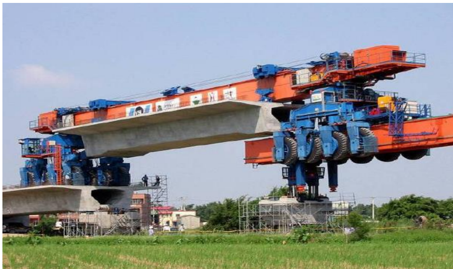
شکل (۸-۲): جاگذاری کل دهانه به روش FSM
