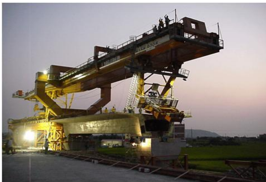
شکل (۷-۲): دستگاه FSM در حال آماده شدن برای حرکت به سمت دهانه بعدی
