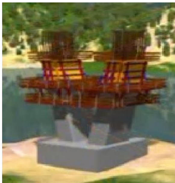
شکل (۵۳-۲) استفاده از قالب پیش رونده
