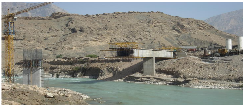
شکل ( ۲-۲۶): اجرای روسازه با استفاده از دستگاه شاریو
