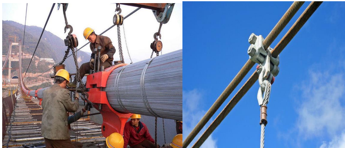
شکل (۲-۶۳): اتصال کابل‌های آویز به کابل اصلی شکل (۲-۶۴): نصب بست‌ها بروی کابل‌های اصلی در عرشه موقت
