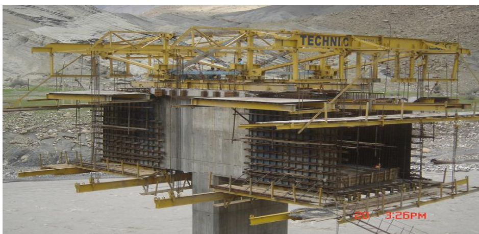
شکل ( ۲-۲۴): جاگذاری دستگاه شاریو روی قطعه اول
