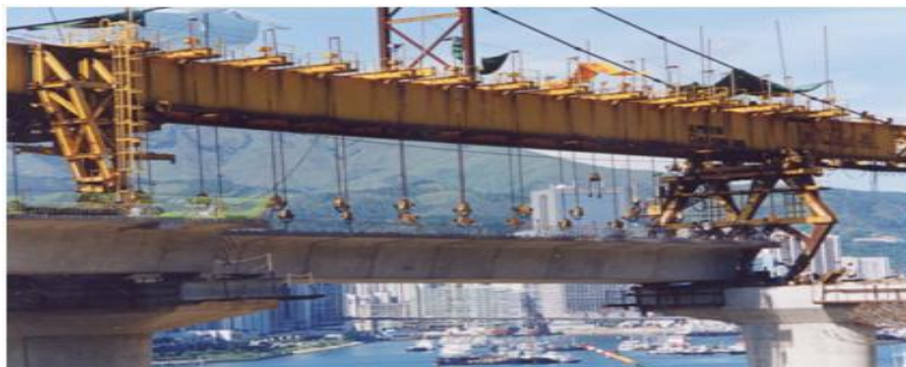
شکل (۲-۴۸) دستگاه LG در حال حرکت به سمت دهانه بعدی
