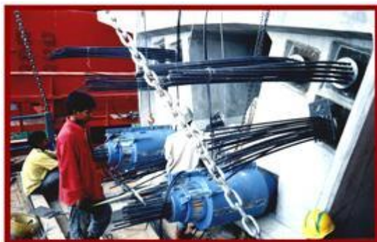
شکل ( ۲-۴۷) کشش کابل ها توسط جک های چند رشته ای
