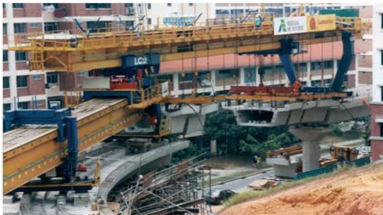
شکل ( ۲-۴۶) اجرای روسازه دارای قوس افقی
