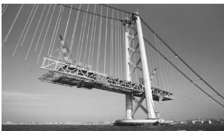
شکل (۶۹-۲): نصب عرشه با استفاده از روش طره‌ای در پل آکاشی کایکو [۲]
