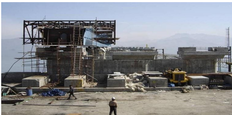
شکل ( ۲-۳۶): اجرای روسازه پل ارومیه با استفاده از روش پیشرانی
