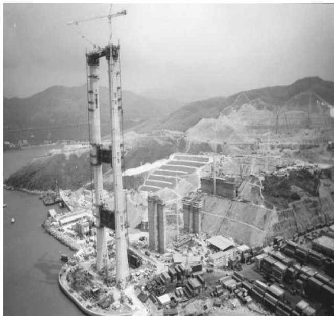
شکل (۲-۶۰): ساخت برج بتنی پل تسینگ ما [۲]
