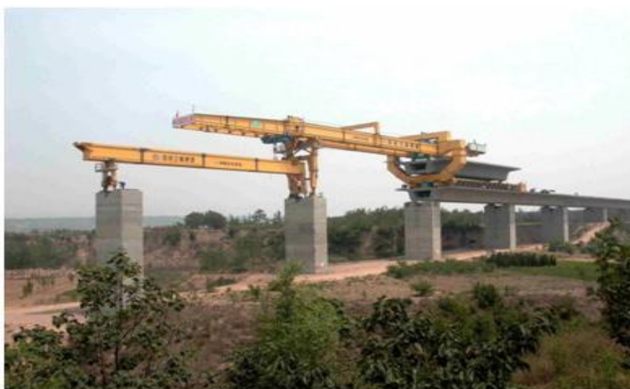
شکل (۲-۵): قرارگیری قطعه پیش ساخته روی دستگاه FSM
