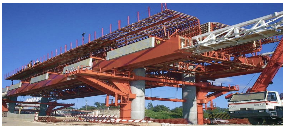
شکل (۲-۱۲): سیستم داربست متحرک MSS
