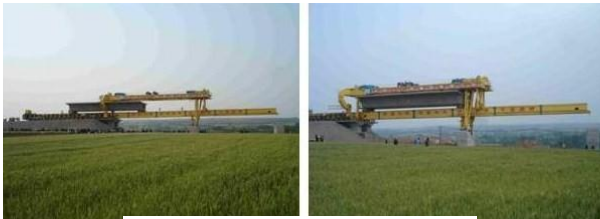
شکل (۶-۲): قرارگیری روسازه در محل نصب
