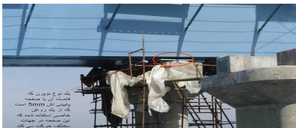
شکل ( ۲-۳۹): استفاده از نوپرن در زیر شاهتیرها در بالای پایه ها - پل دریاچه ارومیه
