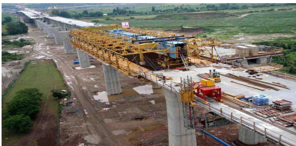
شکل (۲-۱۱): جزئیات سیستم داربست متحرک
