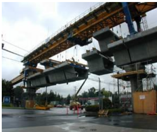
شکل (۲-۴۵): نصب روسازه با استفاده از
