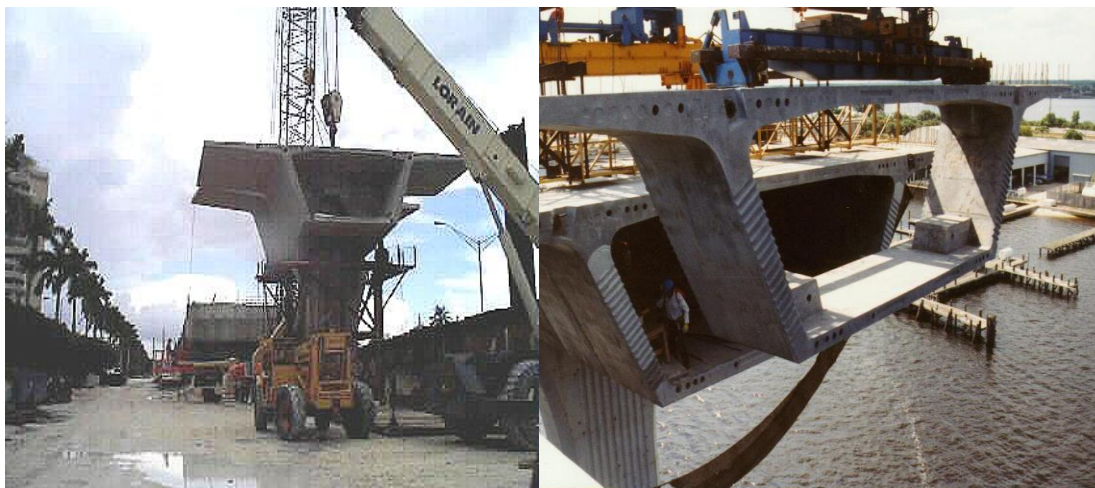
شکل (۲۰-۲): جاگذاری قطعات عرشه صندوق‌های با استفاده از جراثقال
