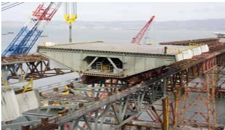
شکل (۱۷-۲): گذاشتن قطعات پیش ساخته روی خرپای موقت
