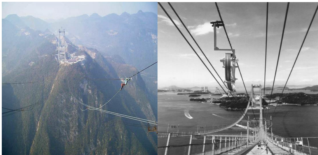
شکل (۶۷-۲): استفاده از روش چرخان هوایی در پل شیموتسویی - ستو و پل سیدوهه
