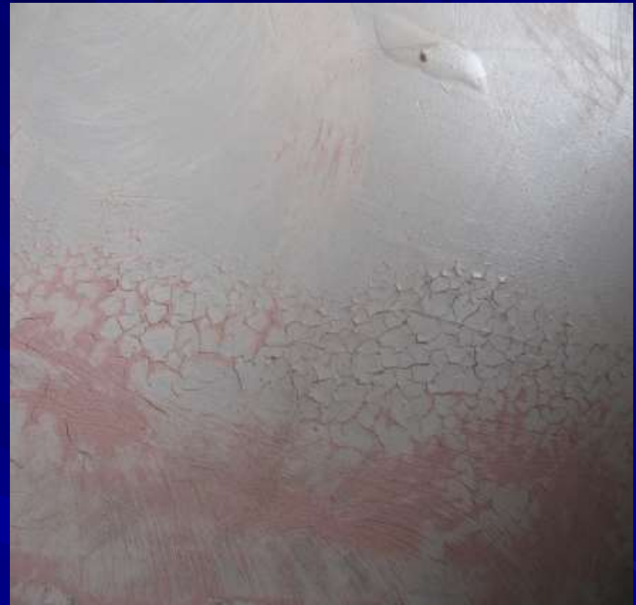
ترک خوردگی سطحی (Checking)
