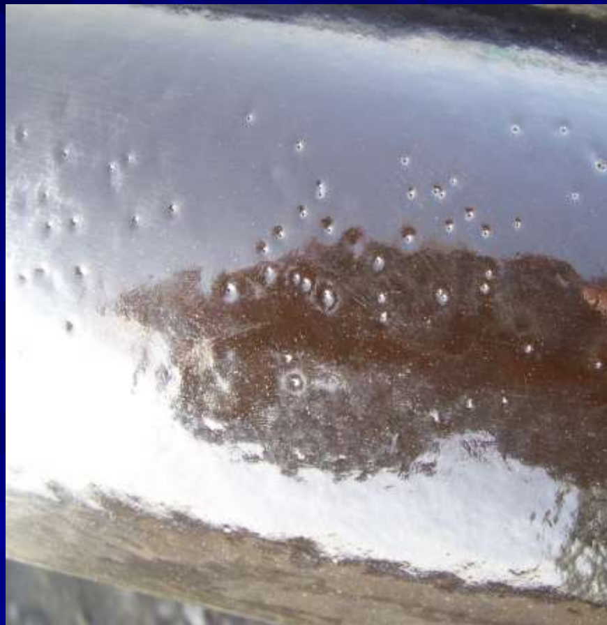
سوراخ شدن (Pinholes)
