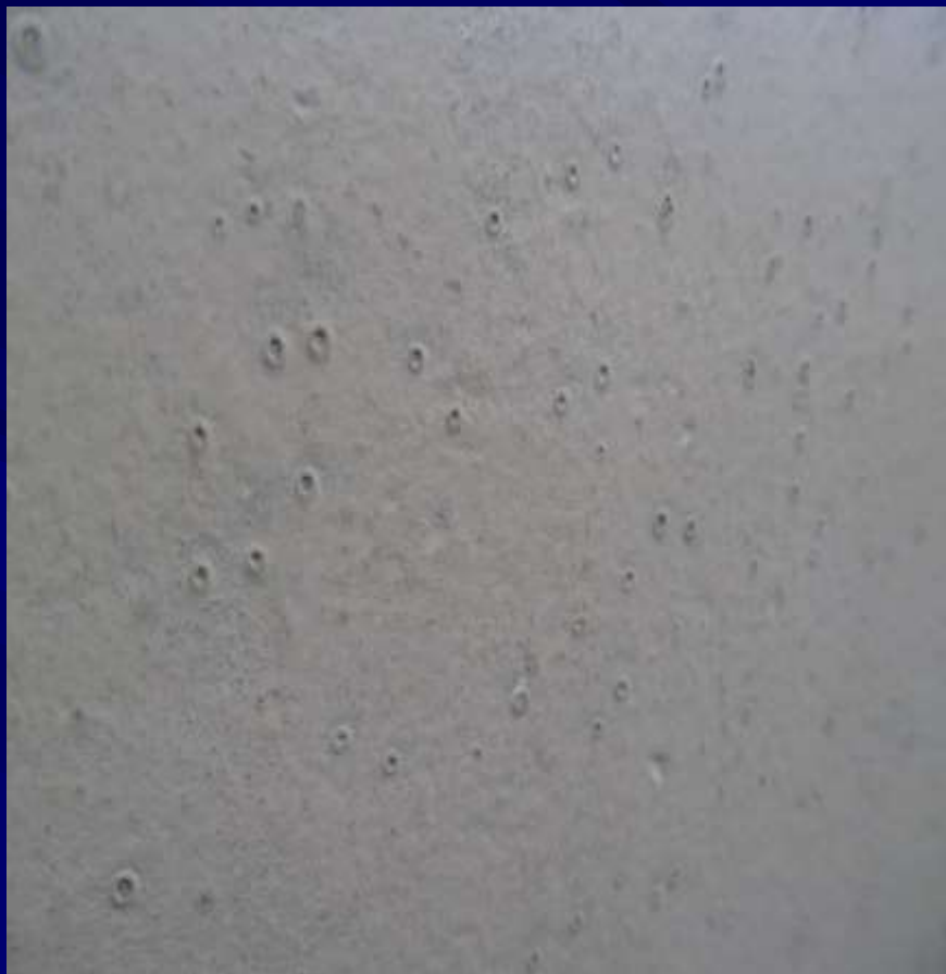
سوراخ شدن (Pinholes)
