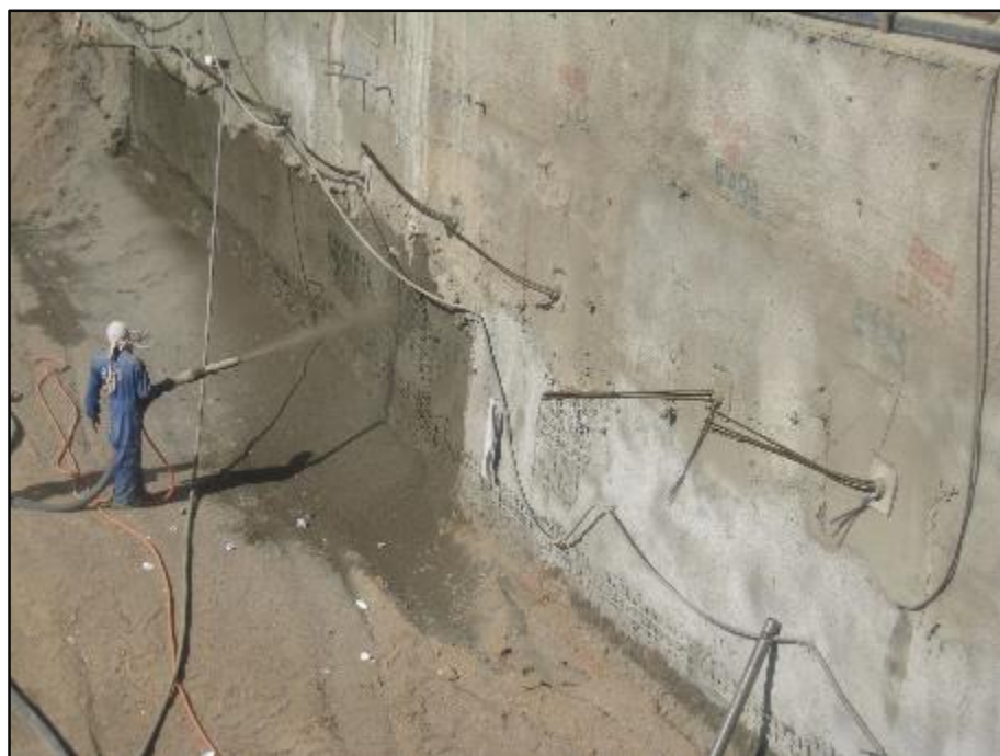
شکل ۷: اجرای لایه موقت مش و شاتکریت
