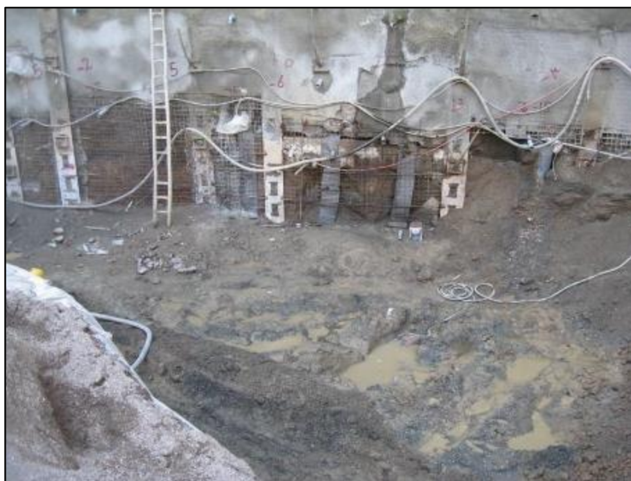
شکل ۳: نصب نوارهای زهکشی در پشت لایه‌ی مش و شاتکریت
