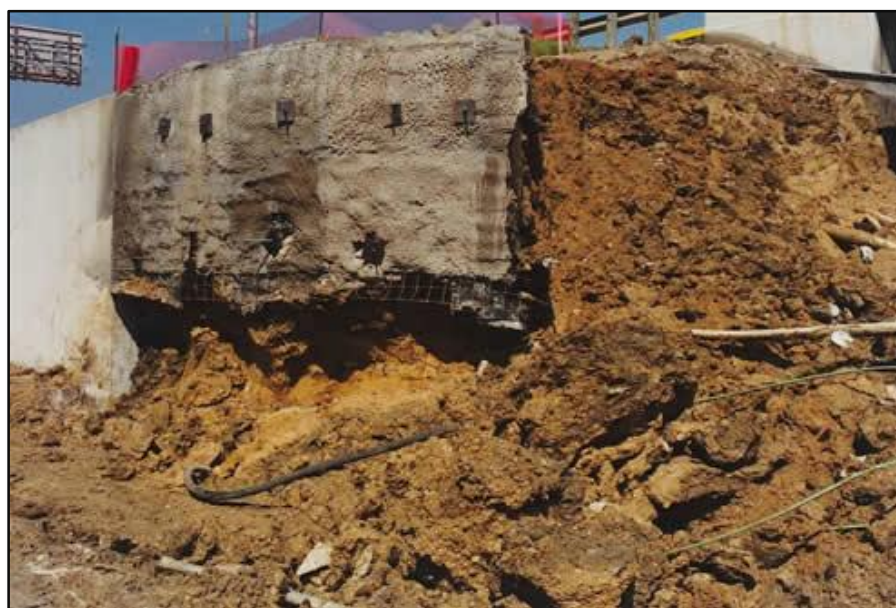
شکل ۱۰: گسیخته شدن دیوار میخ کوبی شده به دلیل اجرا در خاک رسی نرم
