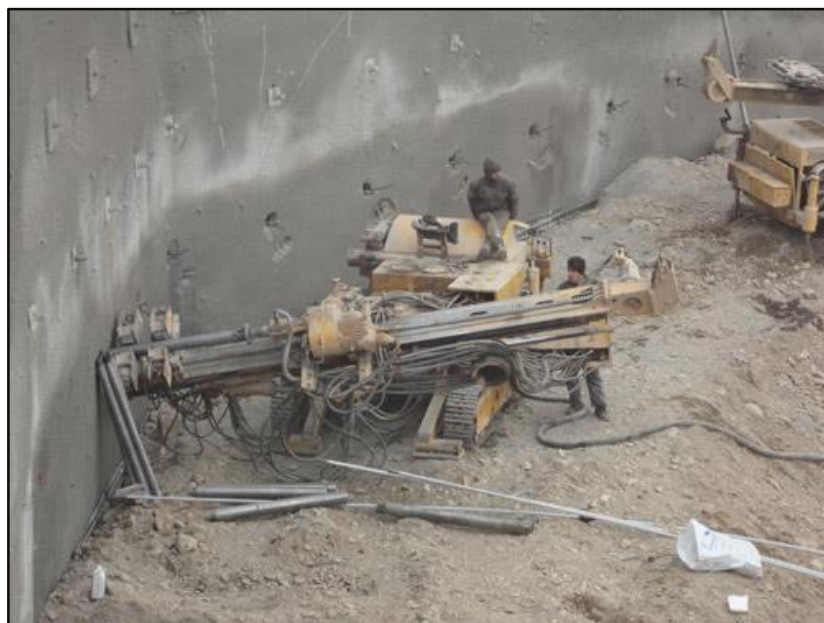
شکل ۵: دستگاه حفاری سوراخ میخ‌ها
