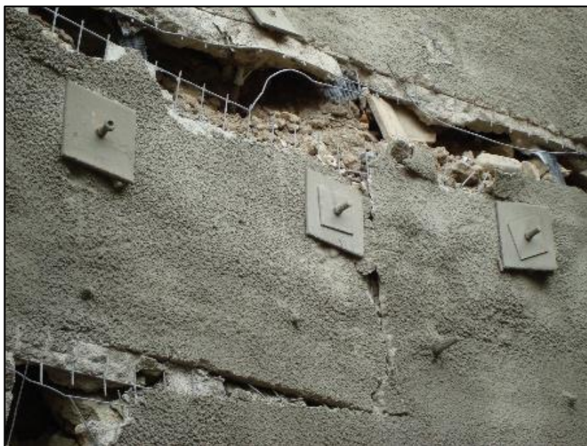
شکل ۸: گسیخته شدن دیوار میخکوبی شده در خاک بدون چسبندگی
