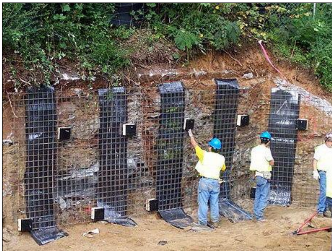
شکل ۱۹: نصب نوارهای زهکشی قائم
