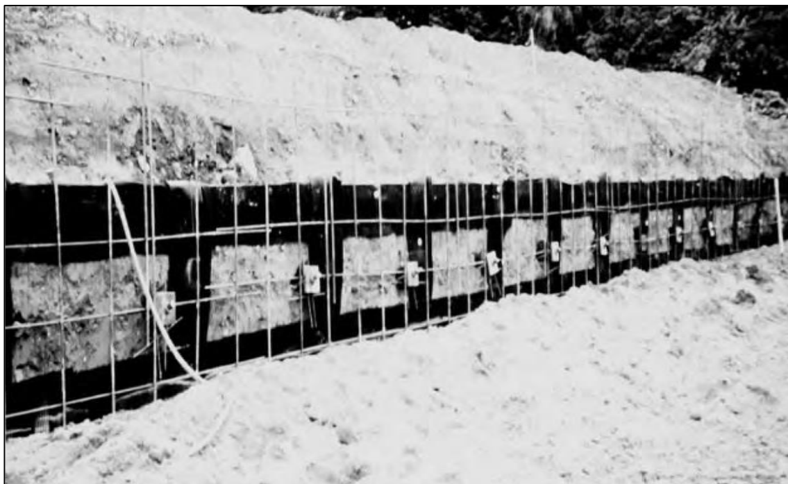
شکل ۲۰: نوارهای زهکشی اجرا شده به صورت شبکه د پشت یک دیوار نیلینگ
