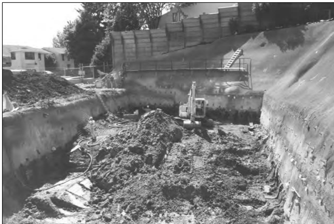
شکل ۱۷: محافظت از شیب با اجرای لایه شاتکریت
