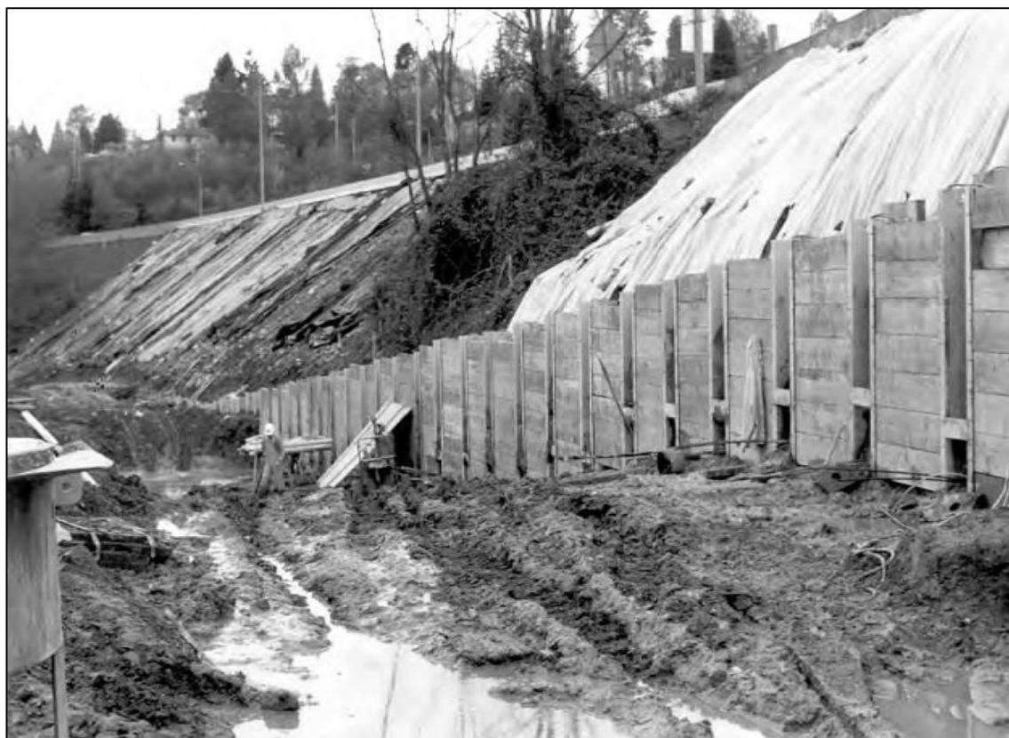
شکل ۱۵: پوشاندن روی شیب با نایلون
