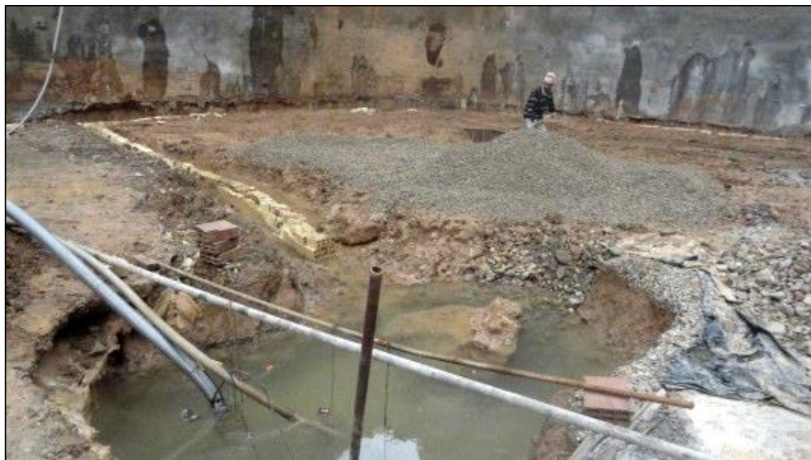
شکل ۴: اجرای کانال‌های آب کشی با سفال و شن درشت دانه
