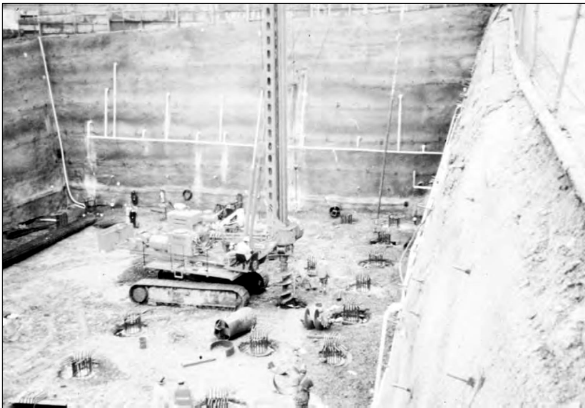
شکل ۱۳: زهکش‌های افقی با عمق تا ۲۱۵ متر (Portland) - به سیستم جمع‌آوری آب توجه شود
