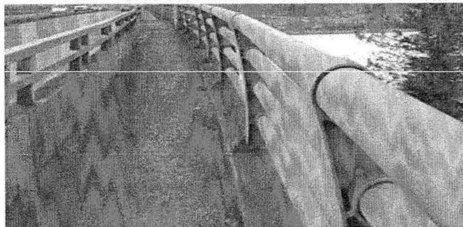
شکل ۳- نحوه نصب نرده پل‌های دارای پیاده‌رو
