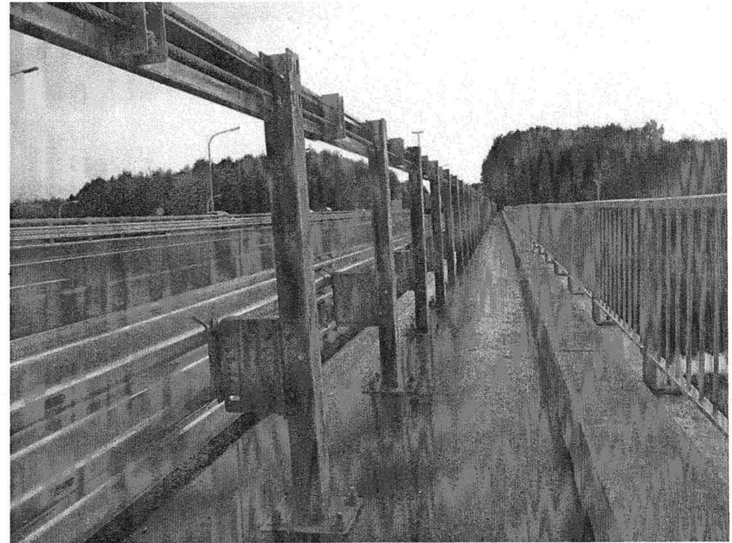
نمونه استفاده از این تیپ حفاظ به عنوان نرده پل
