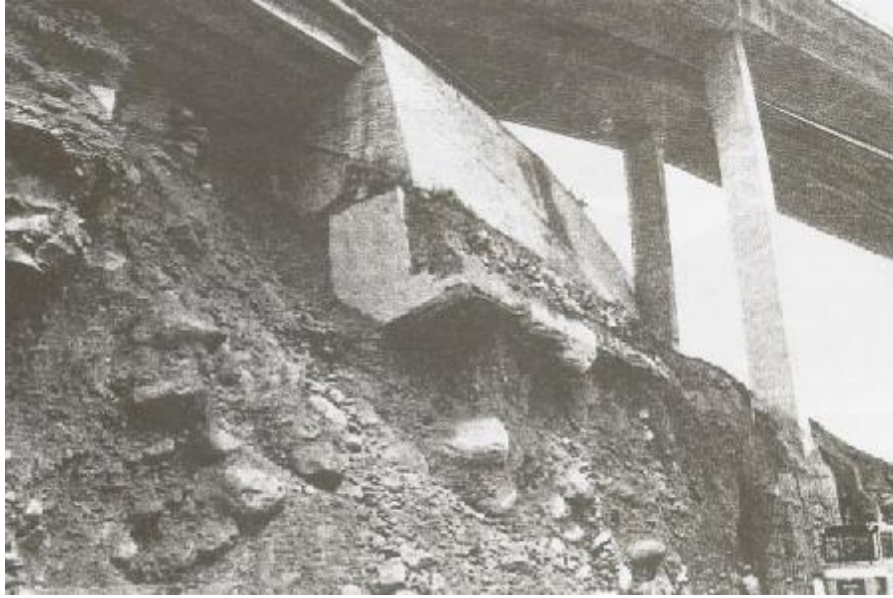
شکل (۱۰-۲) نمایی از زیر فونداسیون پل Reuss
