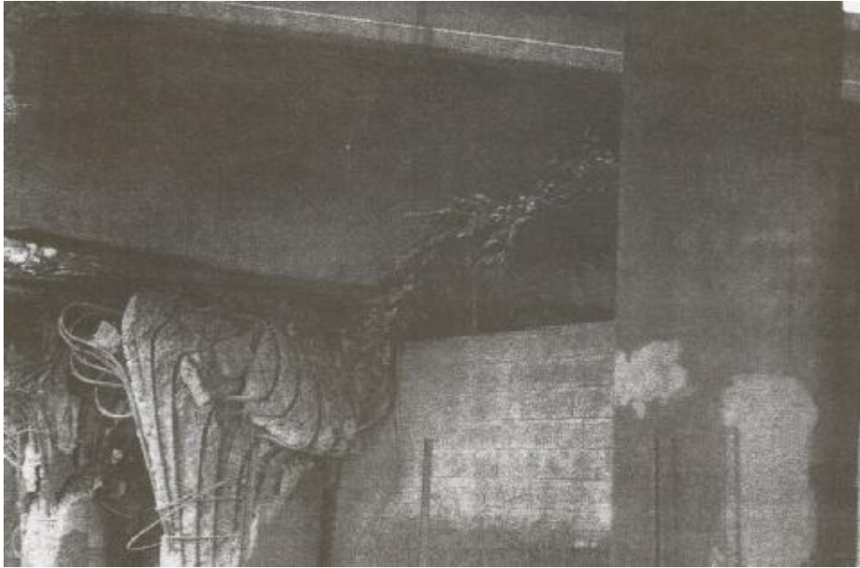
شکل (۲-۳) آسیب‌های وارد به بزرگراه سانتامونیکا در کالیفرنیا در اثر زلزله نرثریج، ۱۹۹۴
