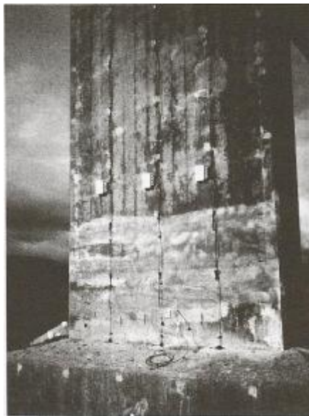
شکل (۴-۴۴) آندها قبل از بکارگیری مصالح پوششی
