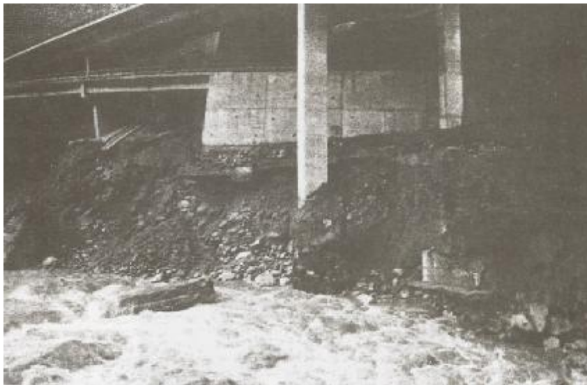
شکل (۹-۲) نمایان شدن فونداسیون پل Reuss
