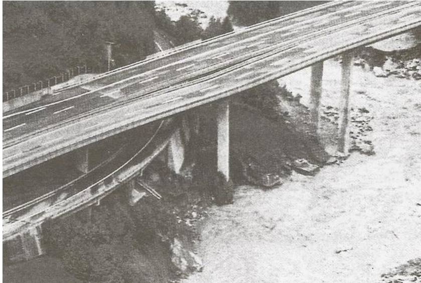
شکل (۸-۲) فرو نشست پل Reuss در منطقه Wassen در کشور سوئیس، ۱۹۸۷
