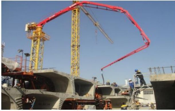
سیستم توزیع بتن متشکل از یک پمپ زمینی و بوم دکل
