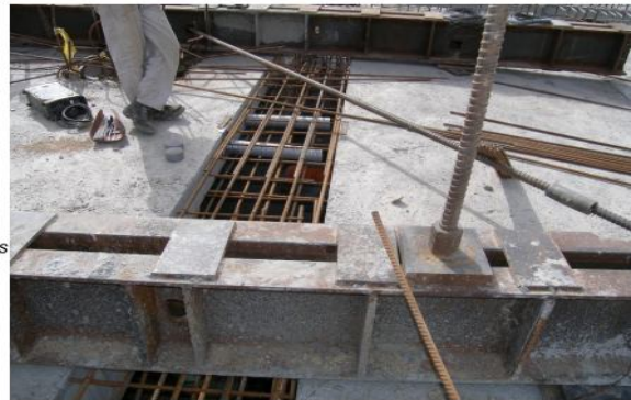
تولید و عمل آوری قطعات صندوقه ای در کارخانه:
