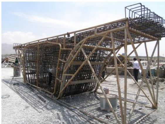
آرماتوربندی هر قطعه با به کارگیری شابلون مخصوص
