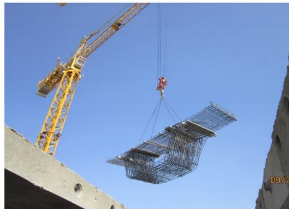
انتقال سبد بافته شده به داخل قالب ها
