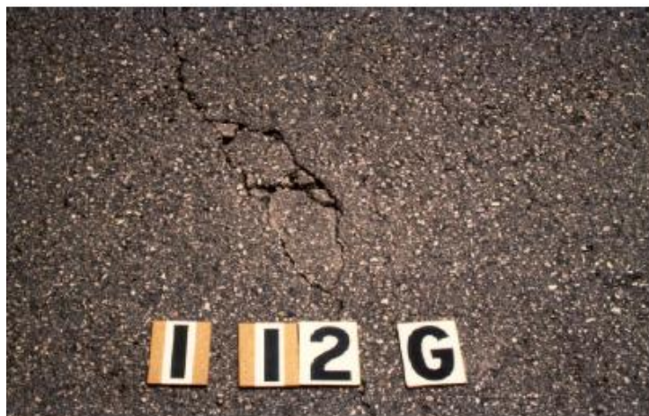
شکل ۲- ترک اولیه همراه با ترک ثانویه
