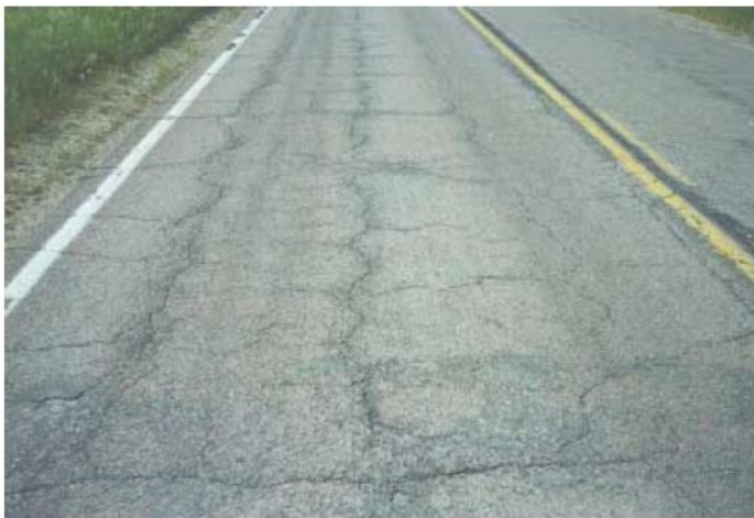
شکل ۳- ترکهای بلوکی
