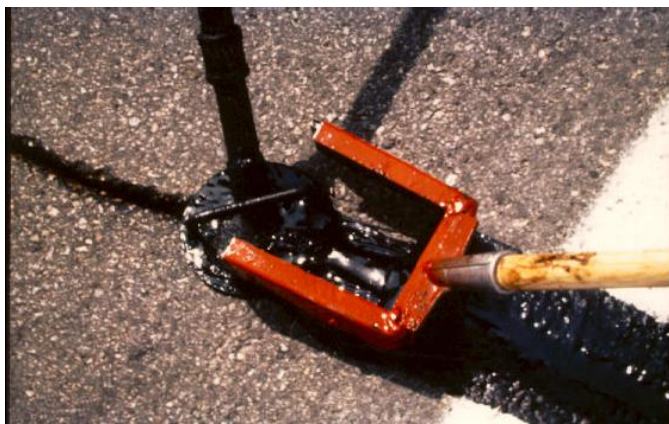
شکل ۵- اسکوئیچی U شکل
