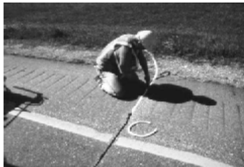
شکل ۳- نصب دستی میله باربر
