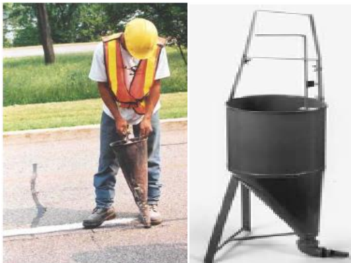
شکل ۶- ابزارهای ریختن قیر امولسیون
