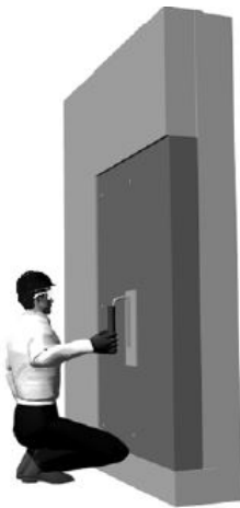
شکل ۵: پرداخت نهایی سطح تعمیر توسط کارگر ماهر
