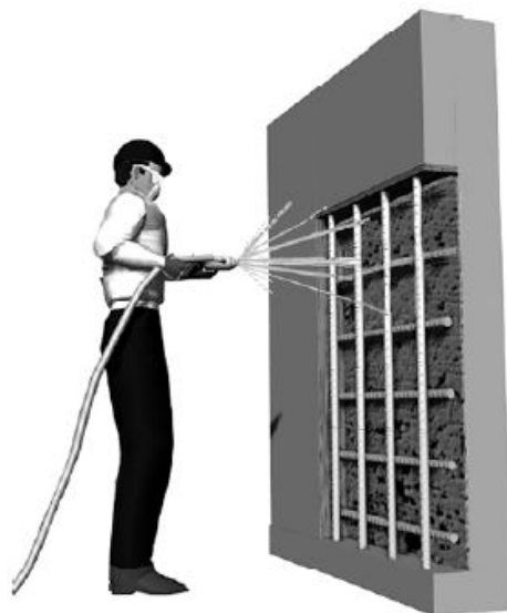
شکل ۳: اشباع سازی سطح آماده شده با آب
