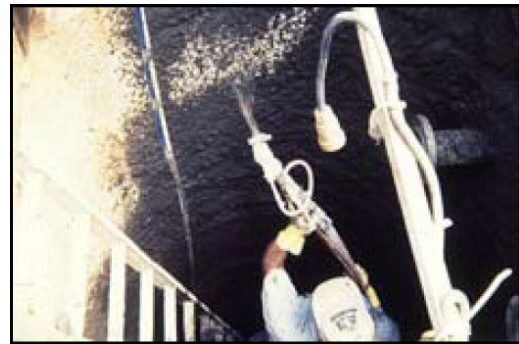
شکل ۸: نمونه‌ای از تعمیر سطوح بالای سر
