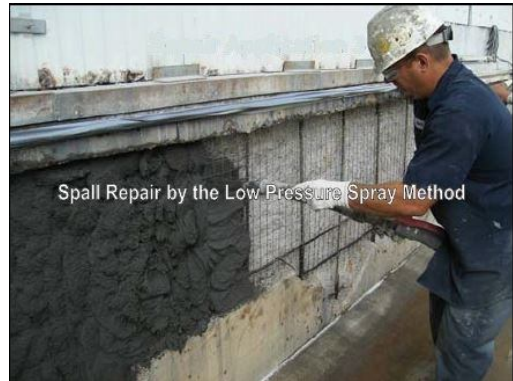
شکل ۷: نمونه‌ای از تعمیر با روش بتن پاشی با فشار کم
