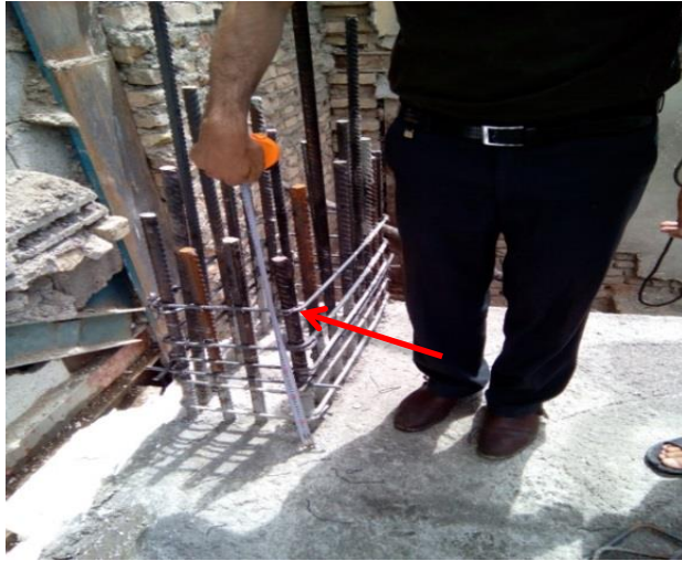
شکل ۲. کوتاه بودن طول وصله پوششی میلگردهای ستون
