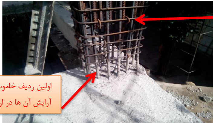
شکل ۷. وضعیت نامناسب خاموت گذاری و عدم مهار آرماتور طولی توسط سنجاقی ها
