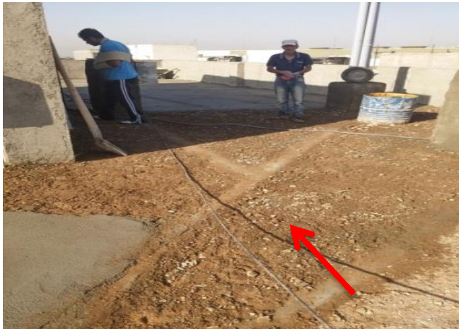
شکل ۲۰. استفاده غیر مجاز از خاک مخلوط در کفسازی طبقات و بام
