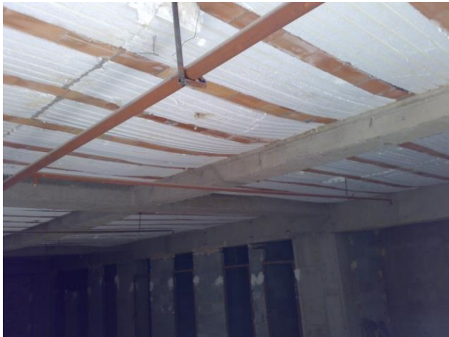
شکل ۱۳. فاصله زیاد آرماتور برشی در شکل سمت راست و خیز نامتعارف تیرچه فوندوله ای در تصویر سمت چپ
