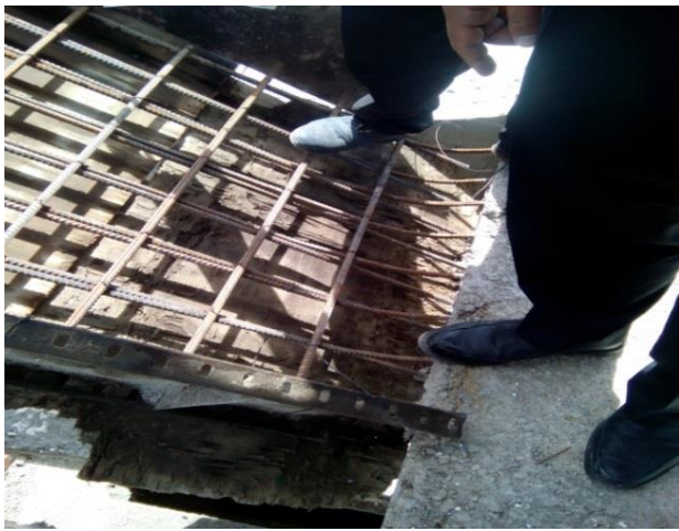
شکل ۸. اجرای آرماتوربندی دال راه پله به صورت شبکه تک لایه
