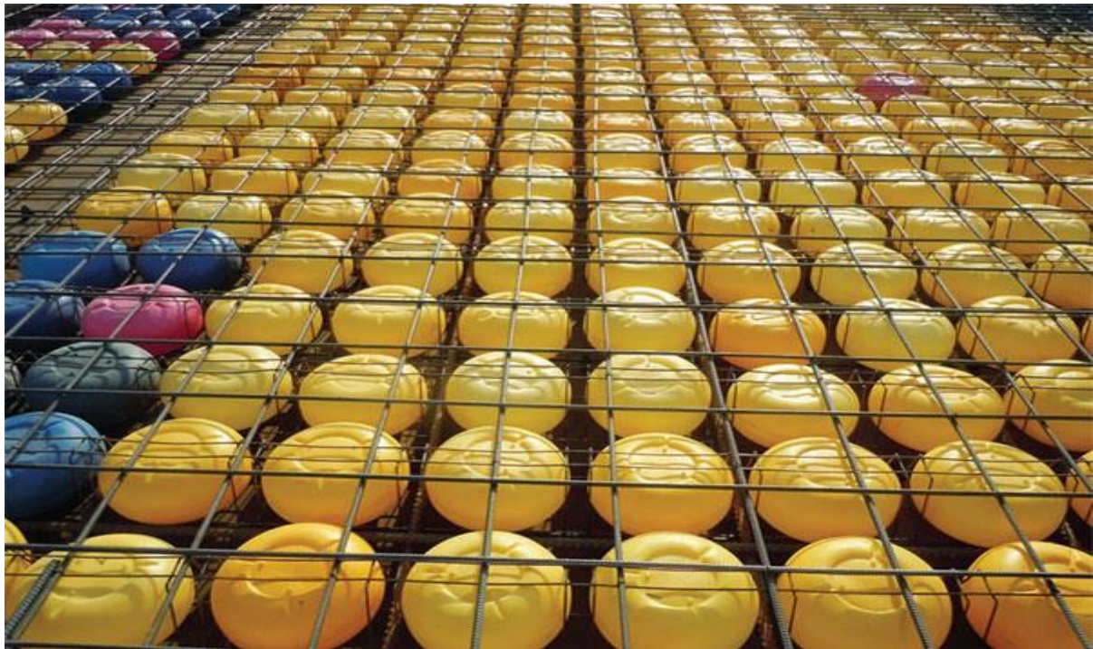
۴. اجرای شبکه آرماتور بالایی
