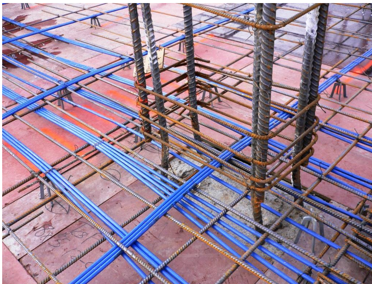
سقف دال بتن (بتن پیش تنیده)
