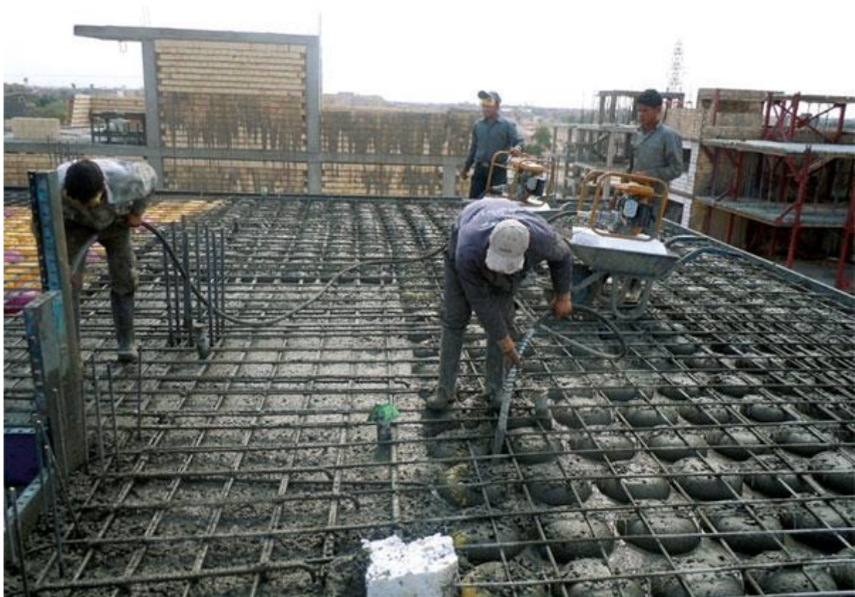
۵. بتن ریزی و ویبره زدن
