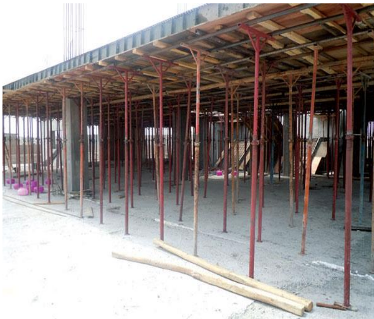
۱. قالب بندی سقف
