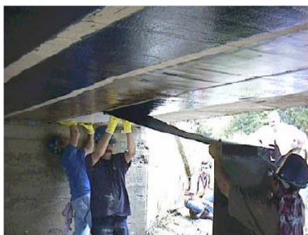
شکل ۱۷- تقویت عرشه پل با ورقه FRP [۱۱]
