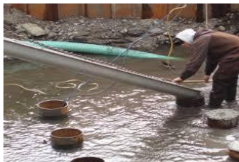
تصویر ۲۲- اجرای شالوده شمعی پایه پل
