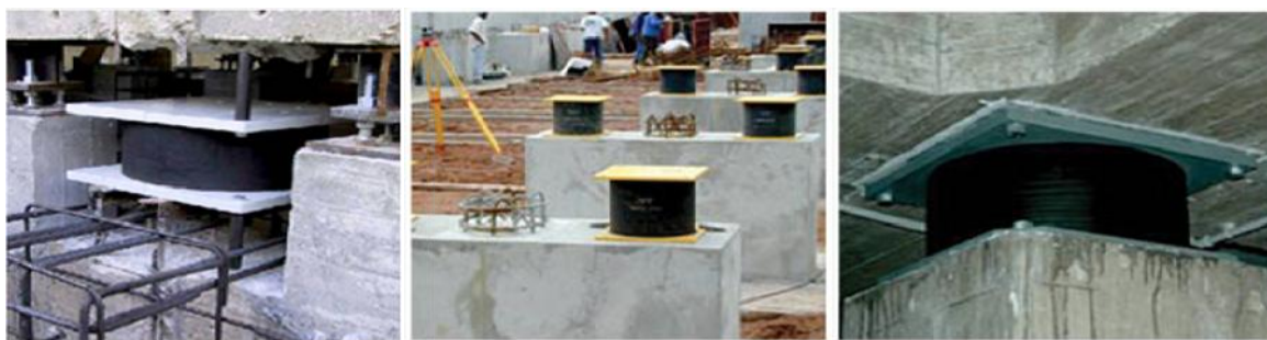
تصویر ۲۶- نصب بالشتک های الاستومری
