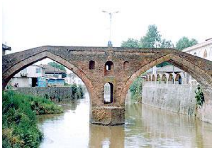
تصویر ۴- پل خشتی لنگرود ( دوران صفویه )
