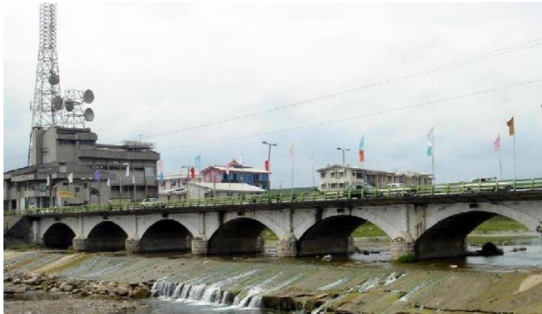
تصویر ۶- پل طاقی ( قوسی ) تنکابن
