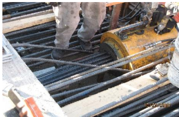
تصویر ۱۲- جک کشش فولادها
