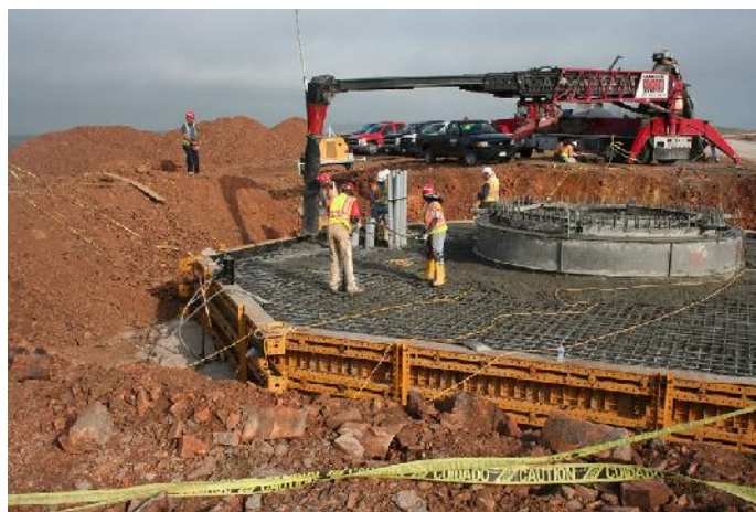
تصویر ۲۱- اجرای شالوده گسترده پایه پل
