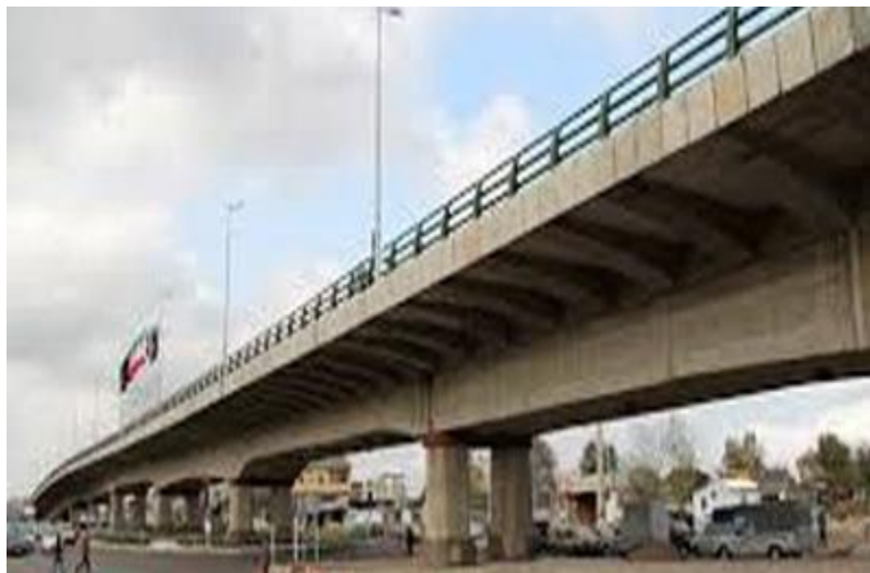
تصویر ۸- پل بتنی دال و تیر ( گلسار رشت )
