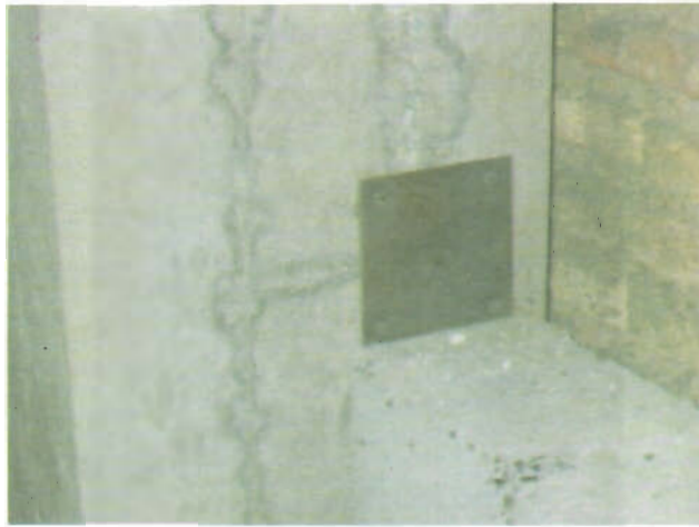
اتصال پلیت توسط چکش فشنگی به ستون بتنی
