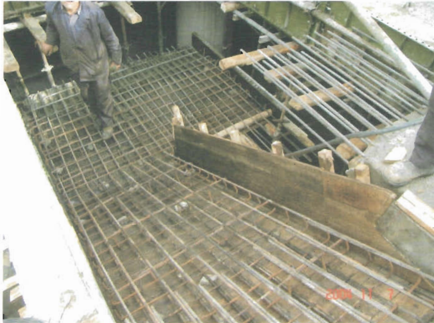
آرماتوربندی و قالب بندی دال پله
