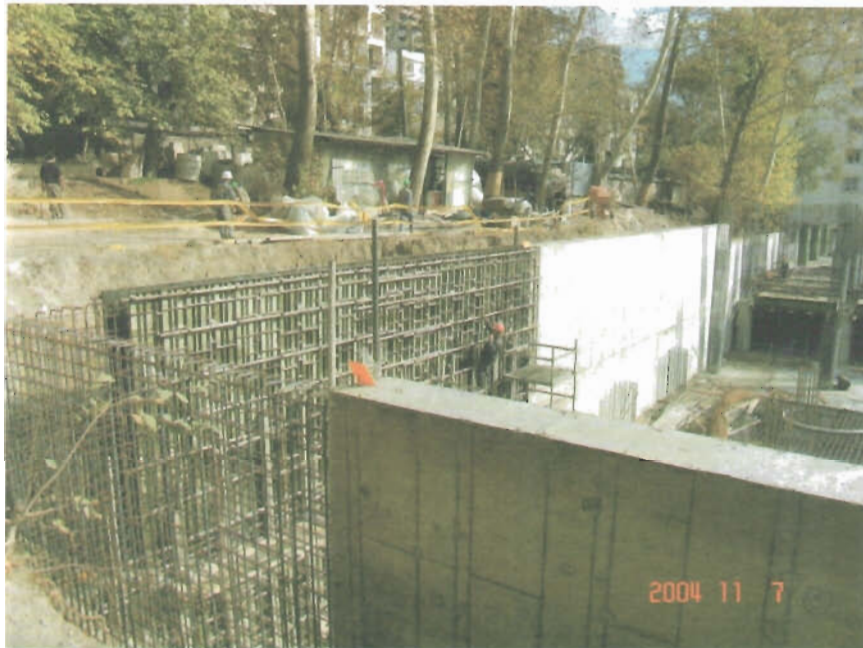
آرما تور بندی و قالب بندی دیوار حائل
