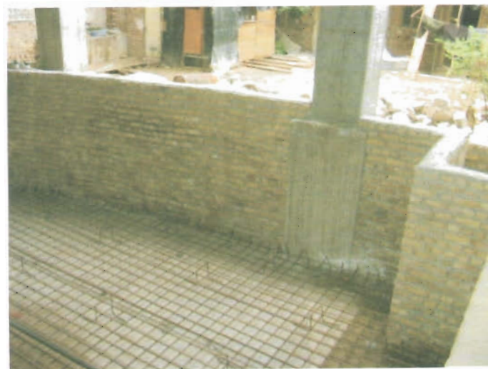
چگونگی مخفی کردن کردن ستون در استخر مطابق با پلان های ارائه شده در فصول قبلی
