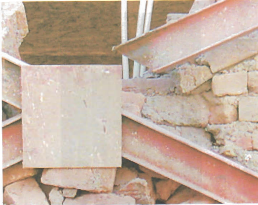
جدا شدن بادبند ضربدری از ورق به علت کوچک بودن ورق مابین
