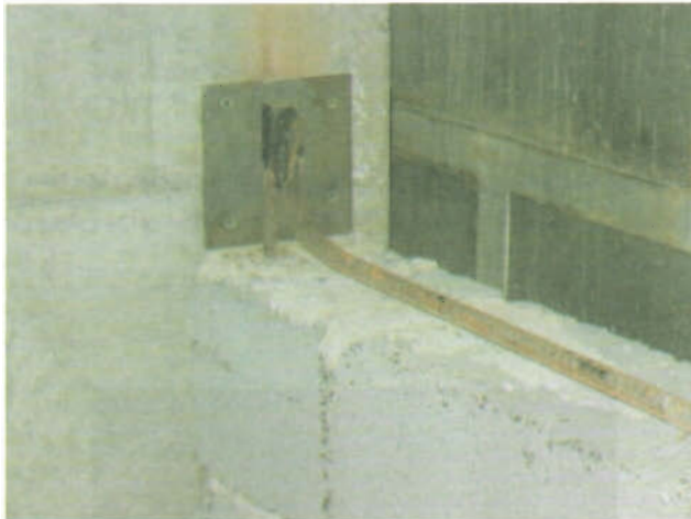
جوش دادن میله گرد به پلیت برای اتصال دیوار به ستون
