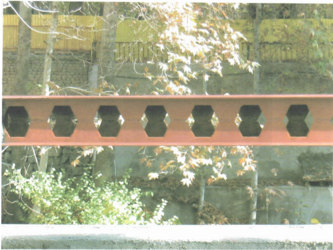
نحوه صحیح دابل نمودن تیرهای زنبوری ( حفره های یک تیر مقابل قسمت بسته تیردیگر )
