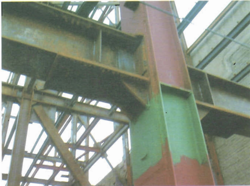
اتصال توسط ورق زیرسری و براکت
