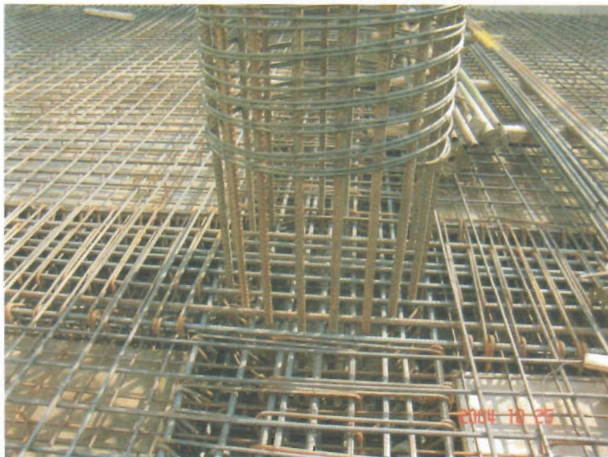
اتصال پوتر به ستون و بستن خاموت در محل اتصال تیریه ستون
