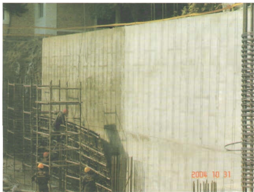
قالب برداری دیوار حائل
