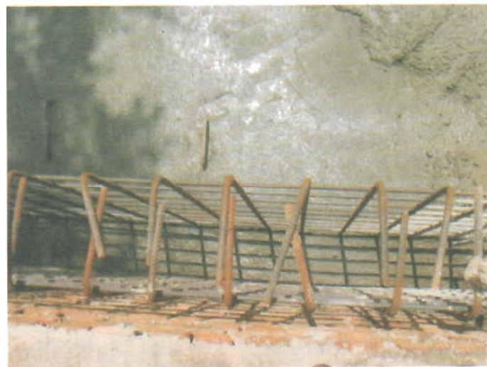
آرماتور بندی دیوار بتنی (دید از بالا)
