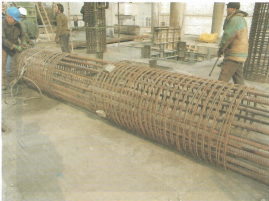
آرماتور بندی ستون بتنی بر روی زمین
