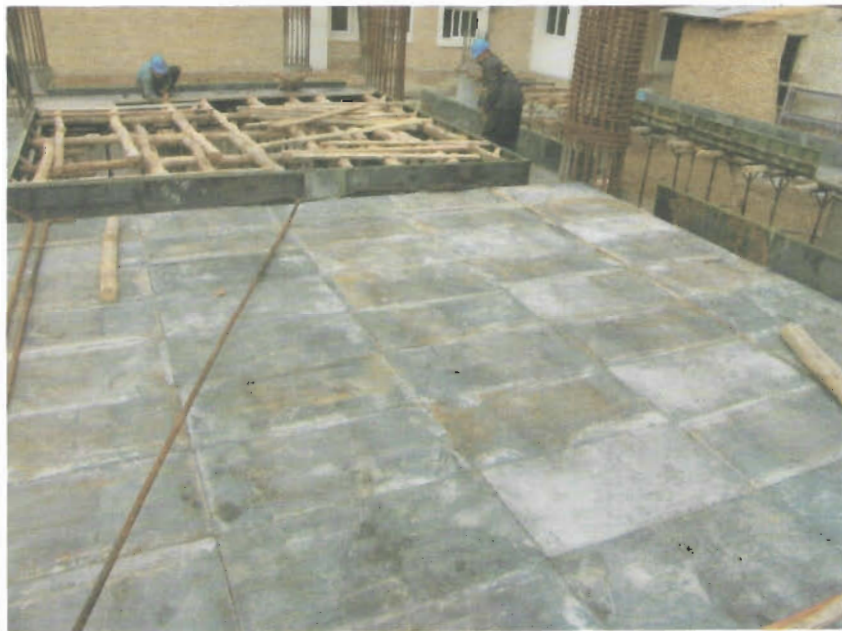
قالب بندی سقف قبل از آرماتور بندی
