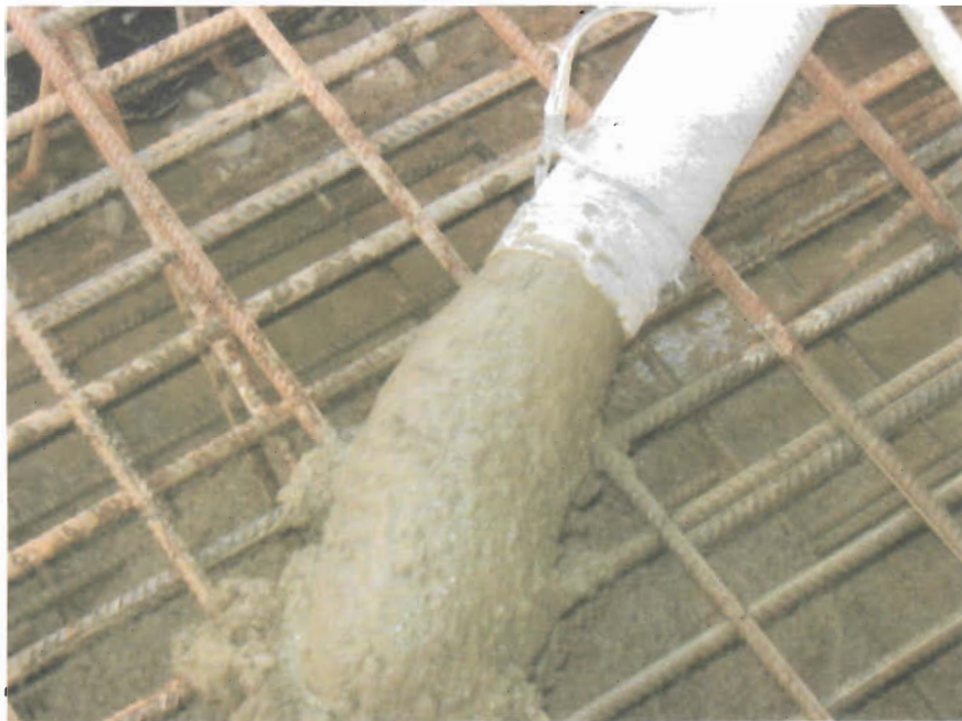
بتن ریزی توسط پمپ
