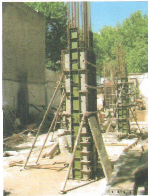
قالب بندی ستون بتنی
