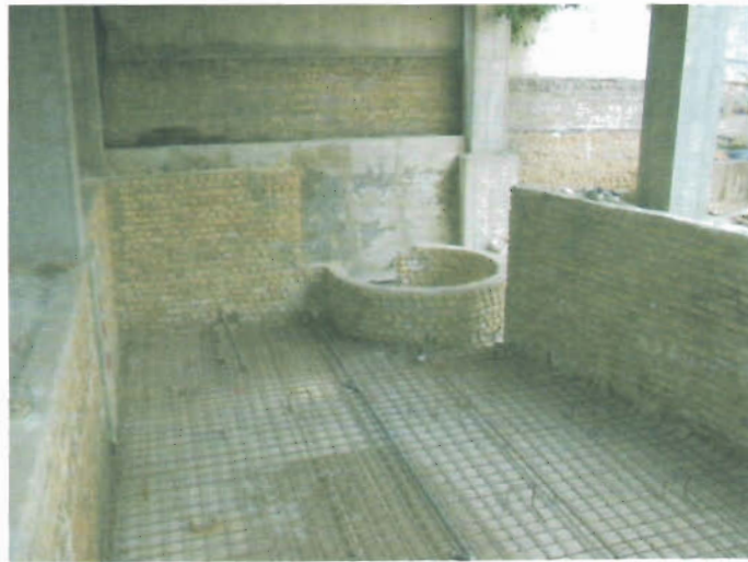
نمای از دیوار چینی استخر و جکوزی قبل از آرماتور بندی و قالب بندی دیوار و شبکه دوم فونداسیون
