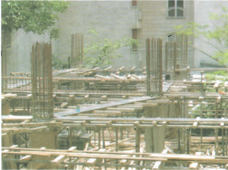
آماده نمودن قالبهای برای سقف و پوتراهای بتنی
