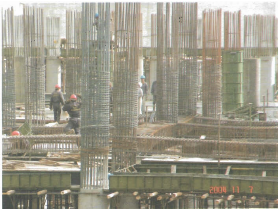
آرماتور بندی ستون بتنی بر روی زمین
