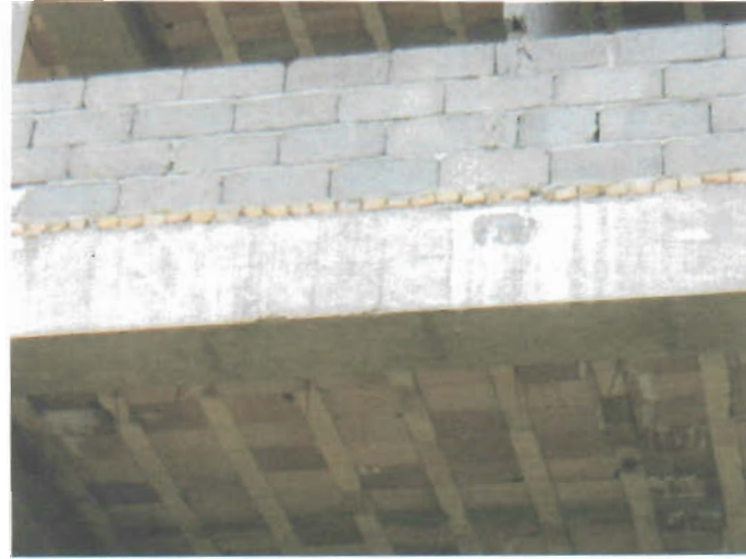
پلیت گذاری در پوتر بتنی ( قبل از بتن ریزی )
