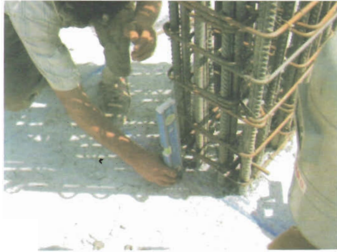
تراز کردن رامکا قبل از قالب بندی ستون بتنی
