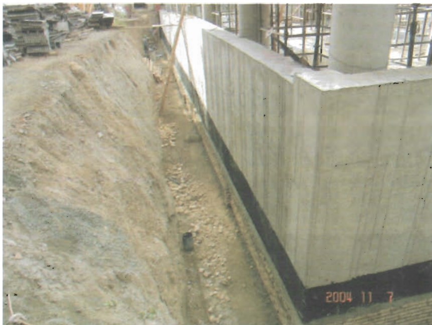
اتصال دیوار حائل در گوشه ها
