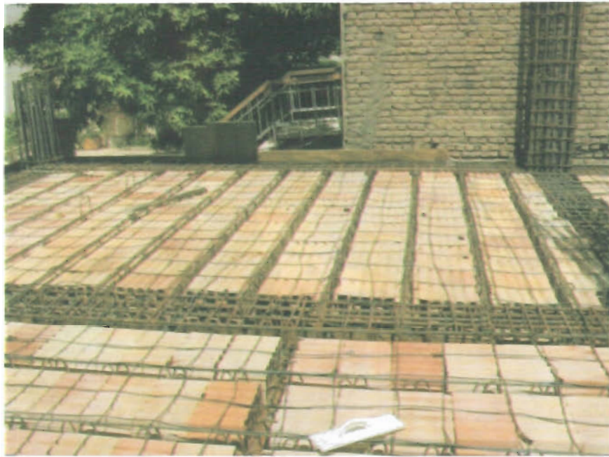
نحوه چین بلوک روی سقف به صورت شطرنجی ( به بستن آرماتور حرارتی توجه شود )
