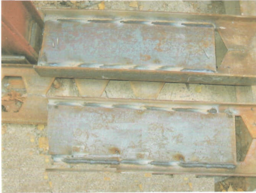
نحوه جوش دادن ورق تقویتی جان در تیرهای زنبوری
