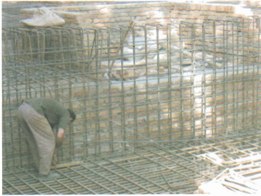
آرماتور بندی دیوار بتنی
