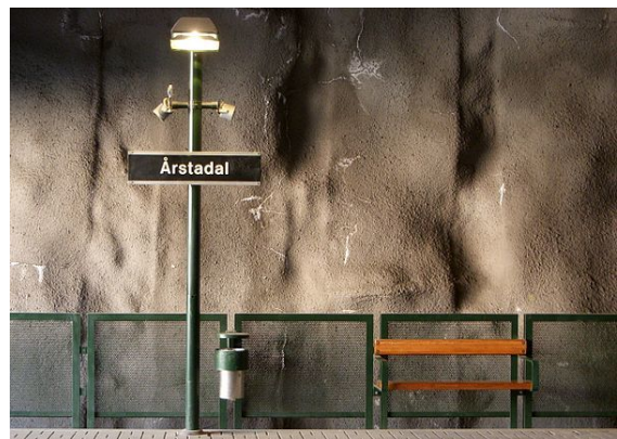
دیوارهای بتن پاشیده در تونلی که ایستگاه آرستادال در متروی استکهلم در آن واقع شده است.
