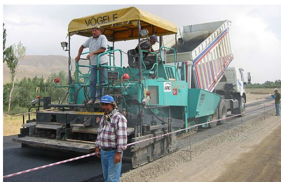
ماشین در حال فرش کردن بتن آسفالتی
