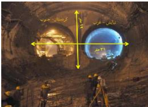
ث- دوراهی کردستان عبور از زیر دریاچه پارک ملت با روباره ۱۵ متر با اجرای سیستم شمع و ریب-عایق بندی دریاچه پارک ملت در مدت یک ماه
