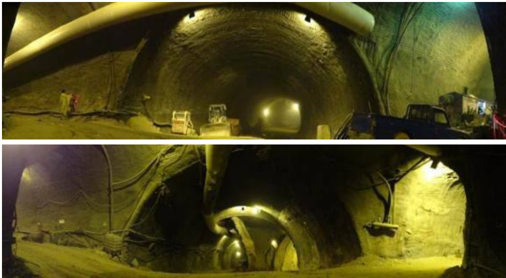
ب- کاهش مدت‌زمان اجرای تقاطع‌ها به یک هفته (در مقایسه با یک ماه زمان اجرای تقاطع تونل‌های دسترسی در مترو)
