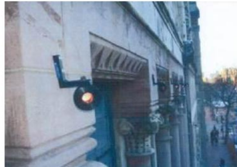
ت- نصب منشور بر روی ساختمان‌ها برای اندازه‌گیری تغییر مکان‌های سه‌بعدی آن‌ها
