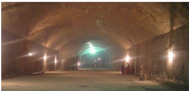
شکل ۱۰- اجرای تونل به روش ناتم: (الف) تونل نیایش در محل سه‌راهی - مراحل اولیه اجرا، (ب) تونل نیایش در محل سه‌راهی - پس از اتمام خاک‌برداری، (ج) تونل خط ۳ متروی شهر تهران (آرشیو شرکت مهندسی مشاور سیویار)
