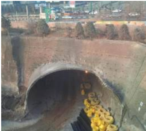
پ- عبور از زیر بزرگراه در حال بهره‌برداری مدرس (با روباره ۵ الی ۸ متر با تونلی به قطر ۱۸ متر)
