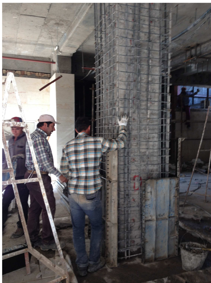
۵-مرحله بعدی قالب بندی ستون،بتن ریزی و بازکردن قالب های ستون می باشد.
