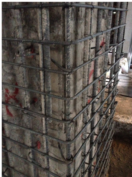
۵-مرحله بعدی قالب بندی ستون،بتن ریزی و بازکردن قالب های ستون می باشد.
