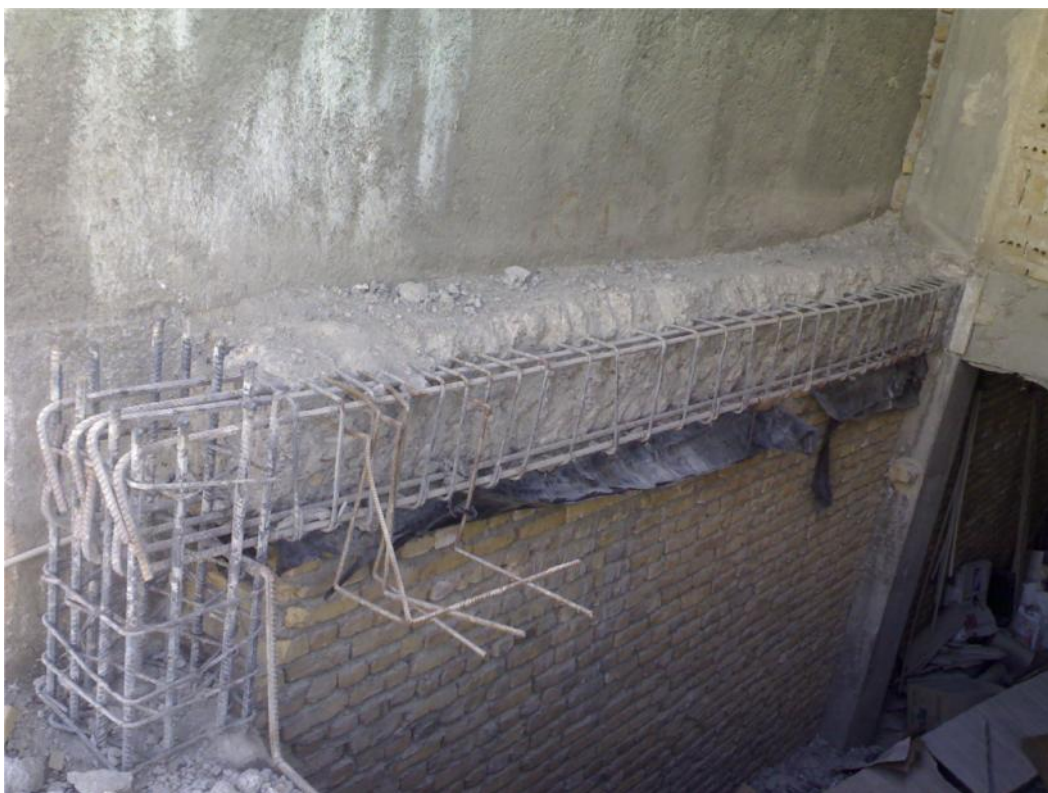
شکل ۱- ساختمان بتن آرمه- مرند - اول بلوار ۲۹ متری جانبازان
