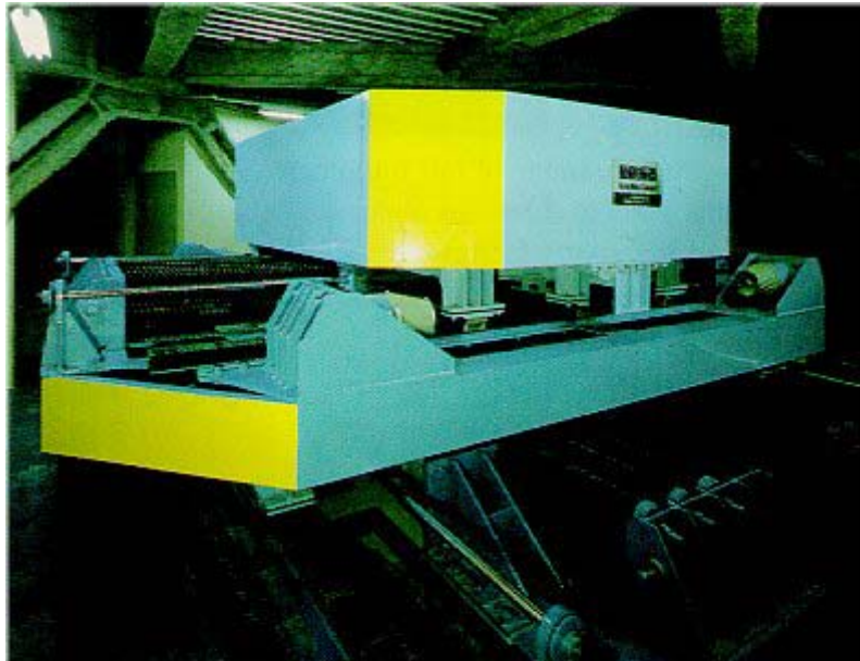
شکل (۴) - میراگر جرمی تنظیمی برای برج بندر چیبایا
