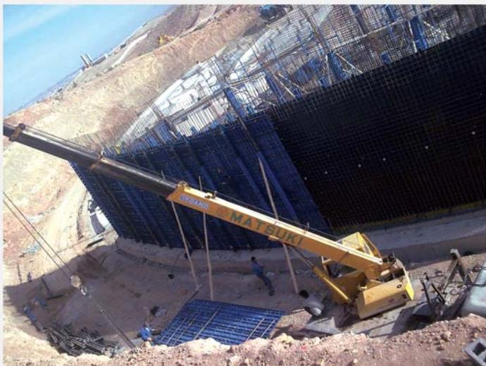
سیستم قالب‌بندی فولادی تخت و استاندارد، متداول‌ترین شیوه در تحقق عملیات سازه‌های بتنی بوده و در عین حال نیازمند آگاهی، تجربه و تخصص در زمینه تولید، موتور و اجرا می‌باشد. تفکر و دید خلاق و دقت در گزینش بهینه پنل‌ها و پشت‌بندها با توجه به حجم، شکل و فشار بتن ریزی بسیار حائز اهمیت و در روند سرعت، کیفیت و هزینه پروژه تاثیرگذار است.
